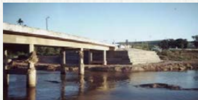
Figura 3 - Reconstrução de aterro de acesso com proteção em gabiões.
