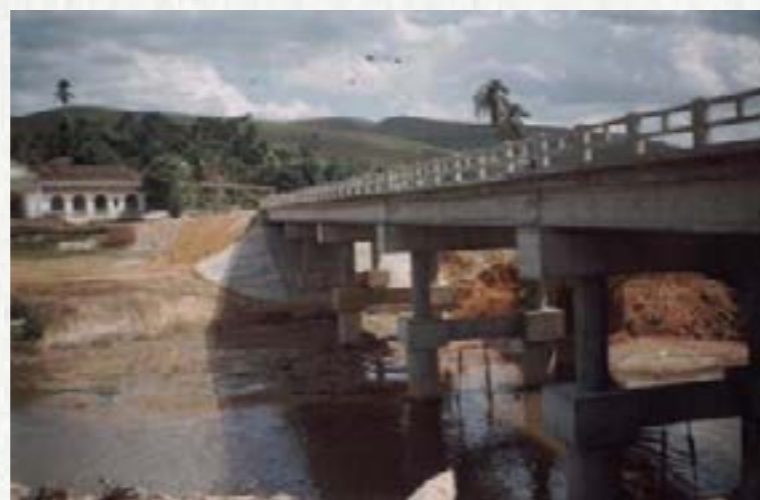
Figura 2 - Reconstrução de aterro de acesso protegido por concreto moldado no local.
