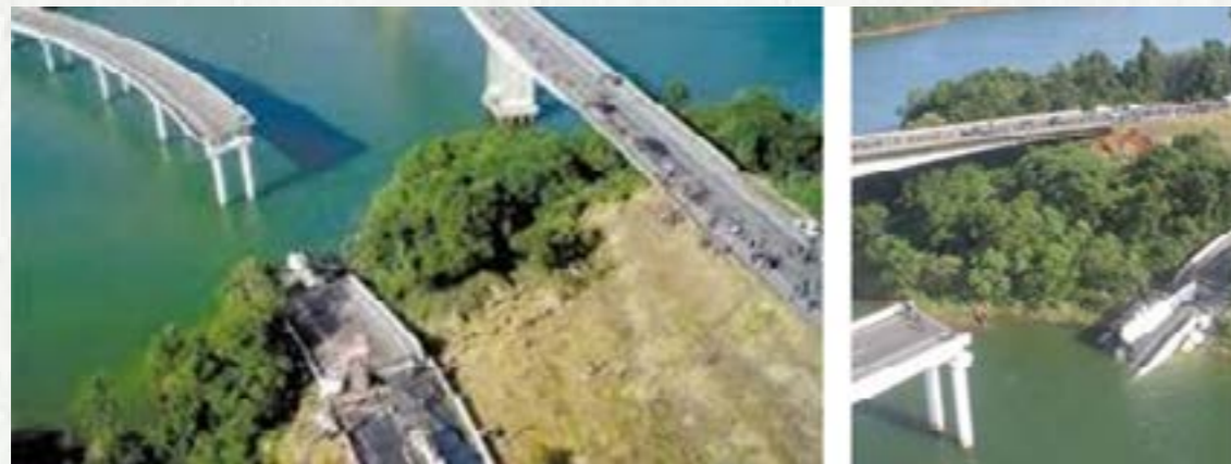
Figura 8 - Aspectos do desabamento da ponte sobre a represa do Rio Capivari na BR 116/PR.
