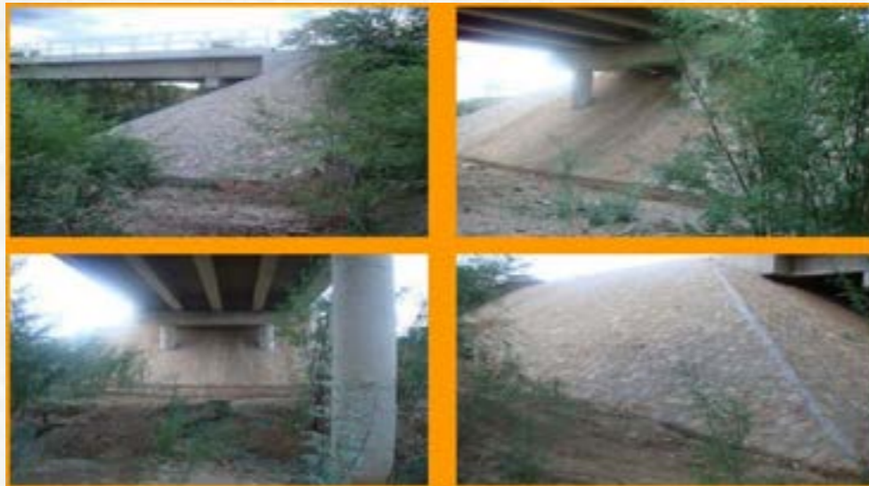
Figura 3 - Taludes dos aterros de acesso de ponte rodoviária com extremidades em balanço, com aterros protegidos com alvenaria de pedra argamassada.
