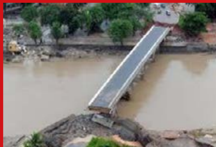
Figura 13 - Vista aérea da ponte após a destruição dos aterros de acesso pela cheia.
