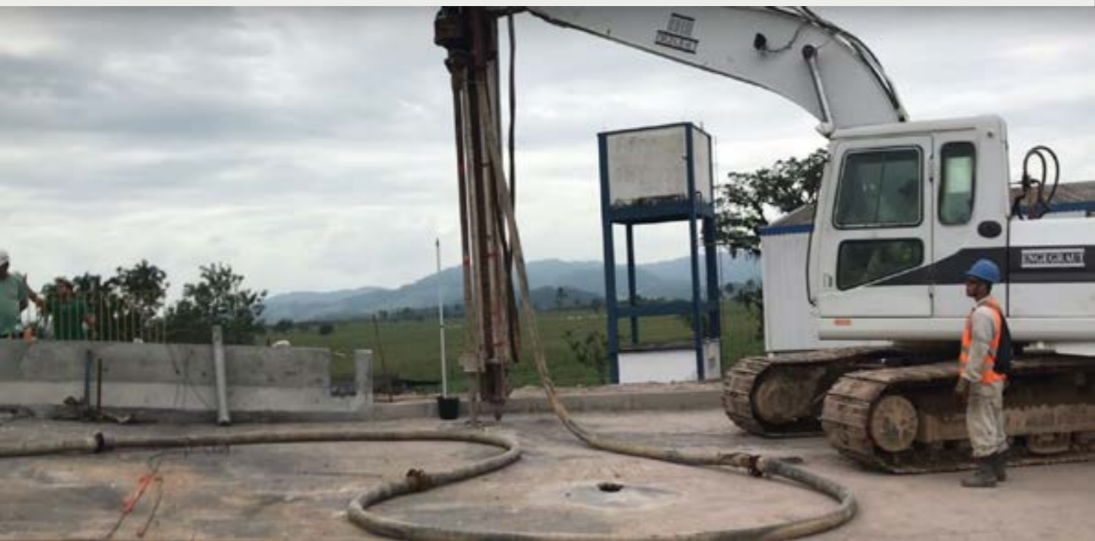
Figura 1 - A intervenção na região dos encontros de pontes e viadutos tem aumentado de forma significativa, devido a presença cada vez mais frequente de ressaltos no pavimento, em decorrência de recalques diferenciais.
