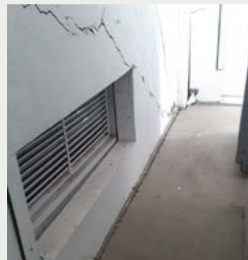
Figura 13 - Rutura à tração na parede deste empreendimento logístico, devido à ausência de melhoramento do solo mole em sua fundação.
