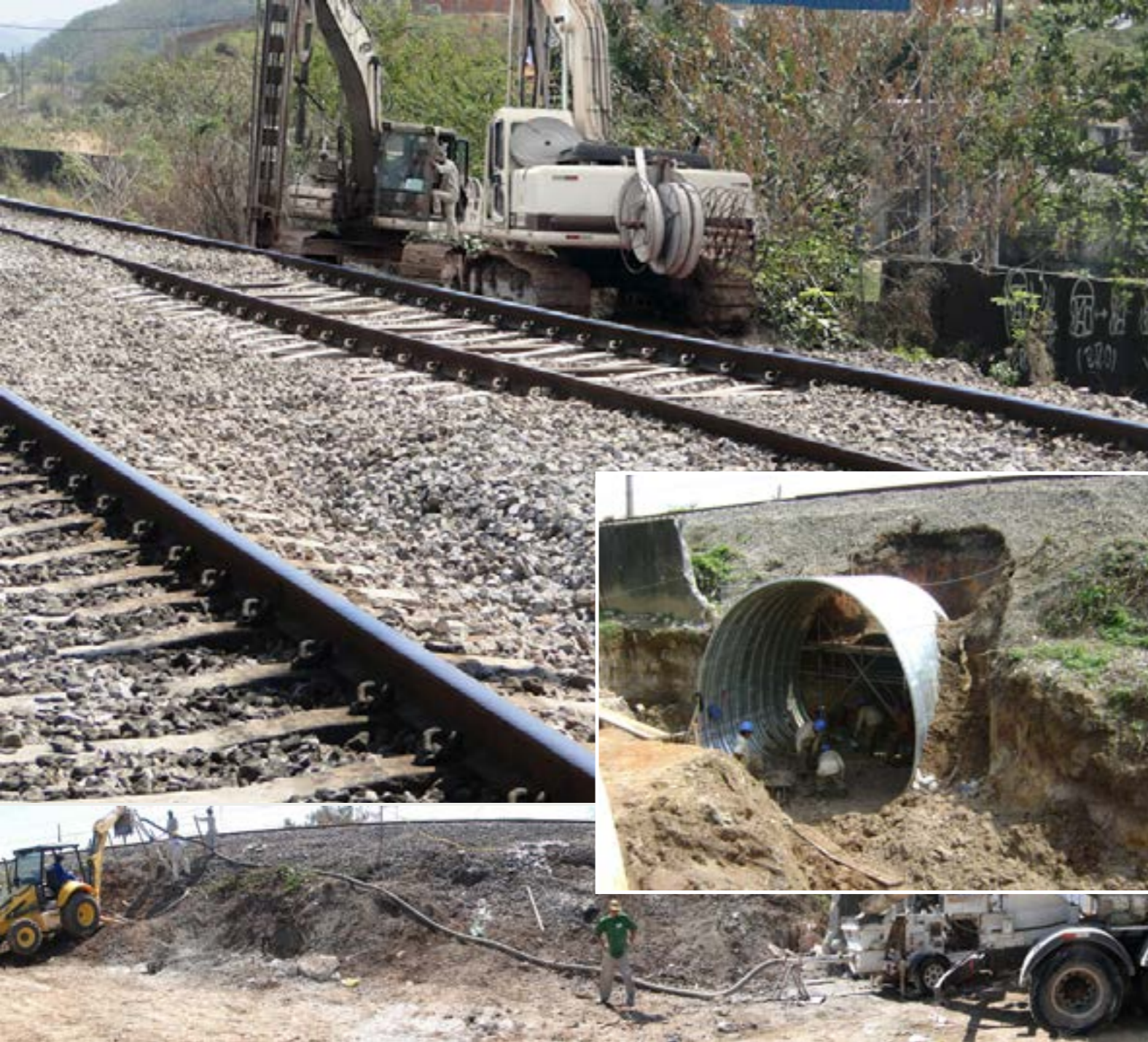
Figura 2 - Execução de uma passagem subterrânea sob uma linha férrea no Rio de Janeiro exigiu a execução de melhoramento do solo com Compaction Grouting (solos arenosos).
