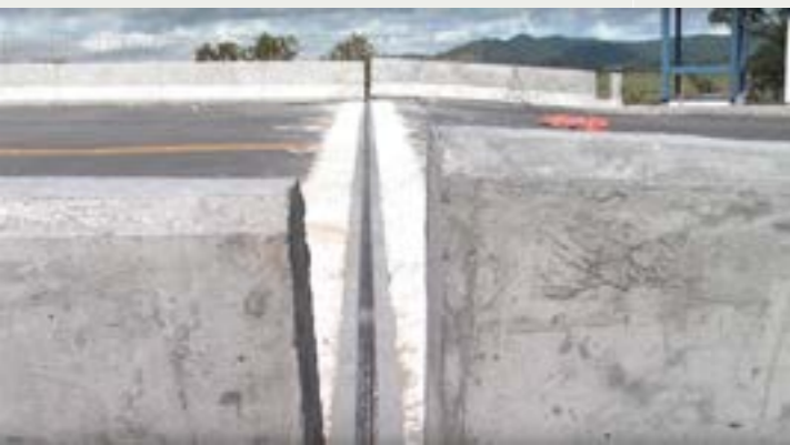
Figura 1 - A intervenção na região dos encontros de pontes e viadutos tem aumentado de forma significativa, devido a presença cada vez mais frequente de ressaltos no pavimento, em decorrência de recalques diferenciais.
