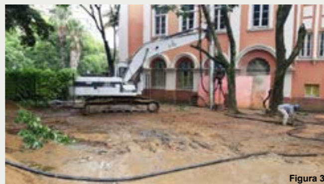
Figuras 1, 2 e 3 - Antigo prédio, com 4 andares e com quase 100 anos tendo fundação direta e corrida, posicionada a cerca de 1,70m de profundidade. Ao longo dos anos, a presença de uma camada de argila mole de 4m de espessura promoveu recalques diferenciais que totalizavam 60cm, exigindo a execução de juntas de dilatação na antiga edificação. O Geoenrijecimento da camada mole com compressão radial com bulbos, via expansão de cavidades foi a metodologia empregada para interromper este sério processo de recalque. Ao longo do tempo ocorreram trincas generalizadas pelas paredes da edificação.
