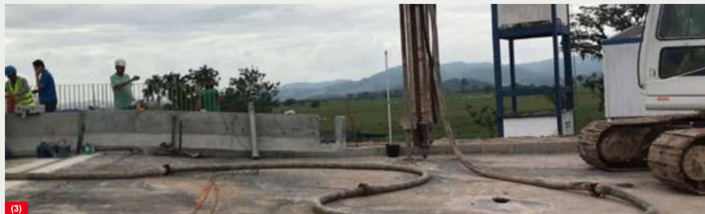
Figura 5 - Na sequência de fotos, (1) o geogROUT adentrando na bomba do geoenrijecimento. (2) a posição da junta de dilatação da ponte, a partir da qual começou os problemas de recalque pela laje de aproximação. (3) furos executos no pavimento e o equipamento de Geoenrijecimento que eliminará a compressibilidade ainda existente, tanto no aterro (mal compactado) quanto no aterro de conquista que apresentava bastante matéria orgânica e turfa.
