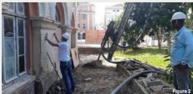
Figuras 1, 2 e 3 - Antigo prédio, com 4 andares e com quase 100 anos tendo fundação direta e corrida, posicionada a cerca de 1,70m de profundidade. Ao longo dos anos, a presença de uma camada de argila mole de 4m de espessura promoveu recalques diferenciais que totalizavam 60cm, exigindo a execução de juntas de dilatação na antiga edificação. O Geoenrijecimento da camada mole com compressão radial com bulbos, via expansão de cavidades foi a metodologia empregada para interromper este sério processo de recalque. Ao longo do tempo ocorreram trincas generalizadas pelas paredes da edificação.
