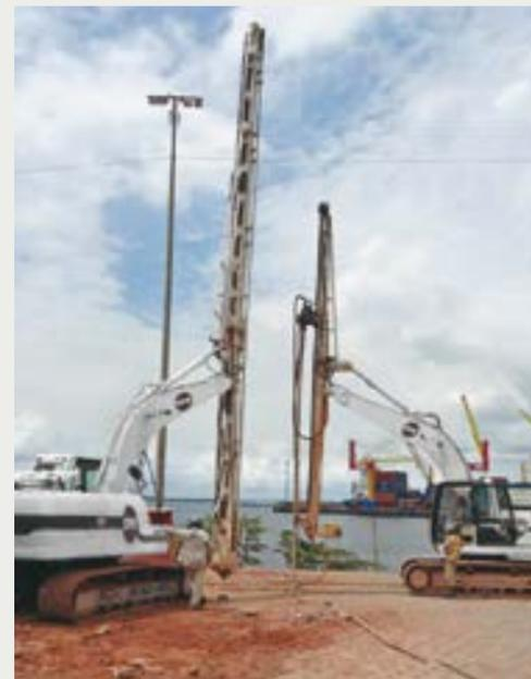
Figura 8 - Zona do cais, com georrijecimento do solo, em profundidades de 30m.
