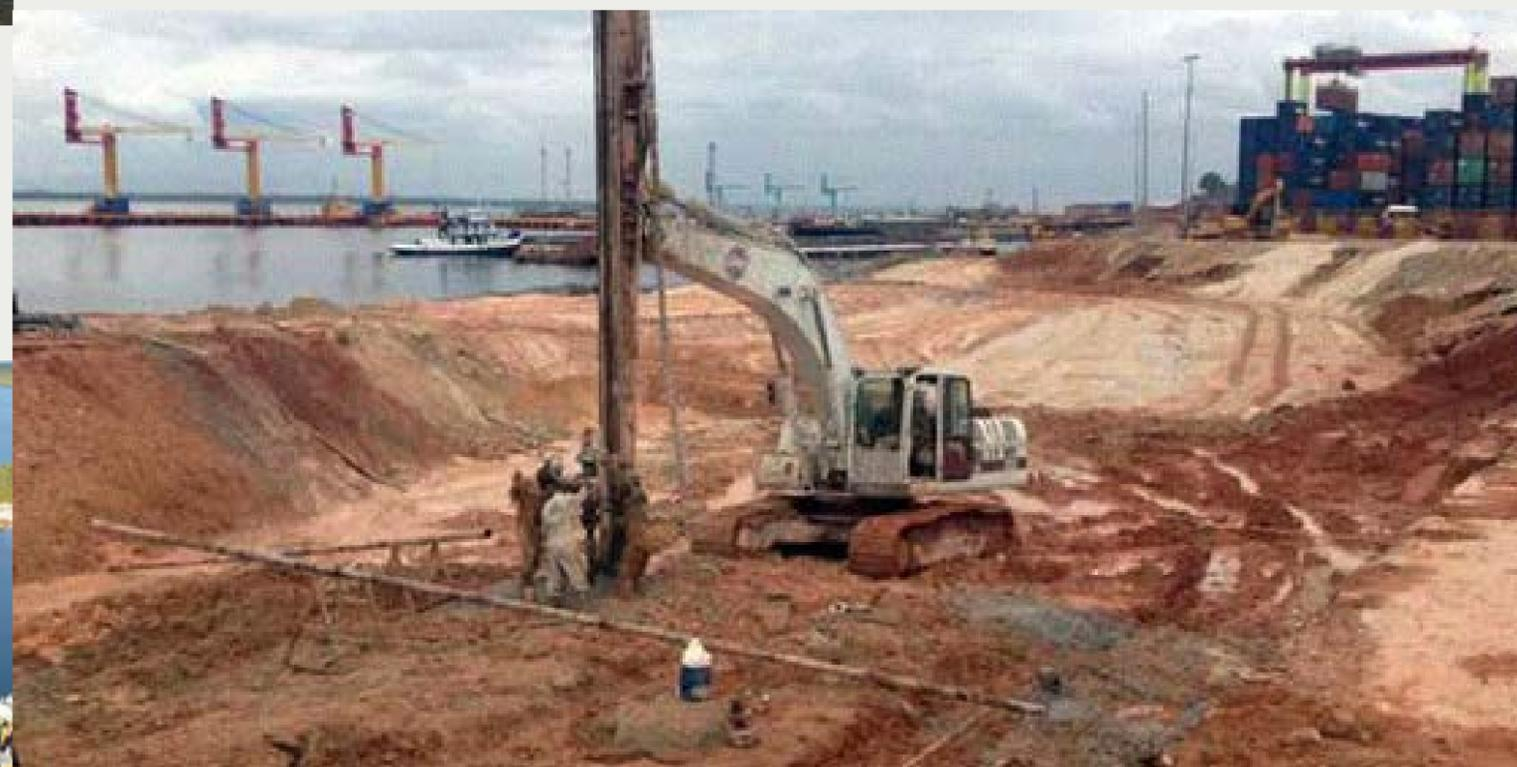
Figura 5 - Serviços de geoenrijecimento sendo executados em região pós-ruptura.
