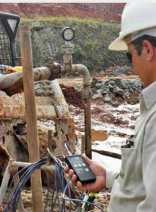
Figura 3 - A certificação do geoenrijecimento com o piezômetro de cordas vibrantes, que atesta o grau de adensamento imposto.
