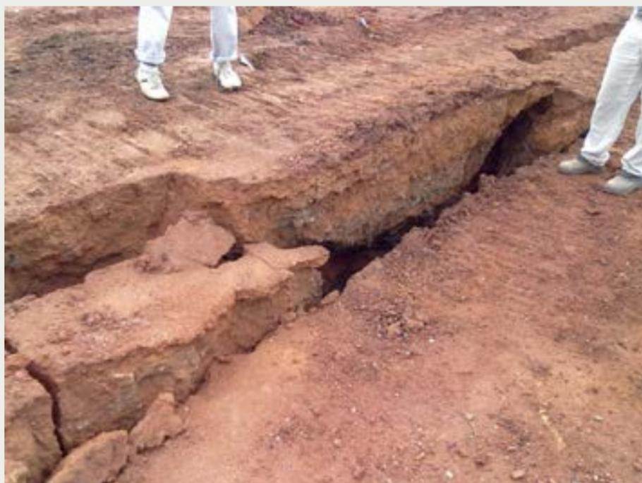
Figura 3 - Rutura de um aterro de sobrecarga, pouco após sua construção. Esta técnica é perigosa e pouco efetiva para melhoramento de solos moles.
