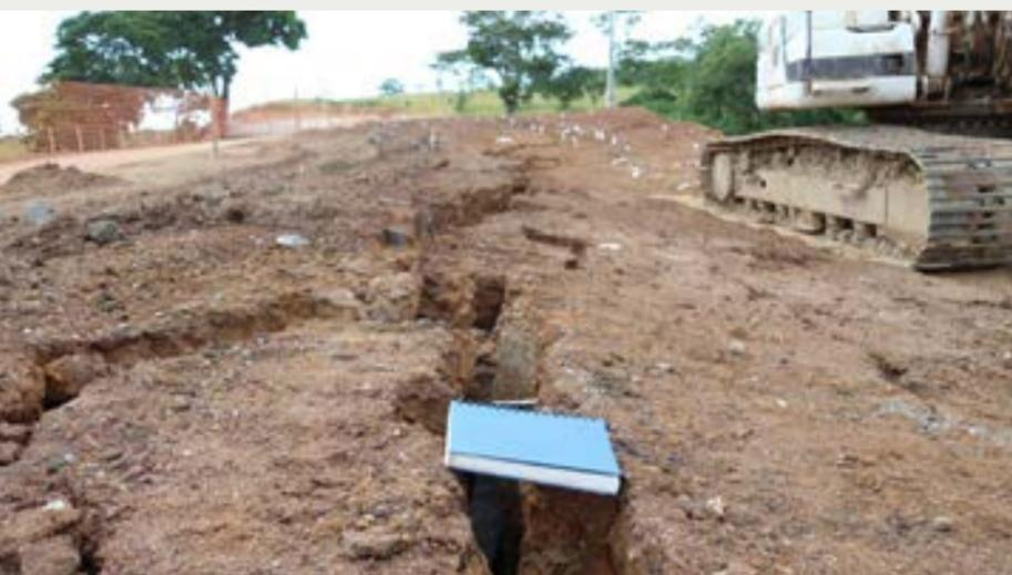
Figura 9 - Princípio de rutura em uma ampliação de estrada sem melhoramento do solo mole. Com a surgência dos sintomas a construtora contratou o serviço de melhoramento do solo, iniciando-se a cravação de geodrenos, seguido do georrijecimento.
