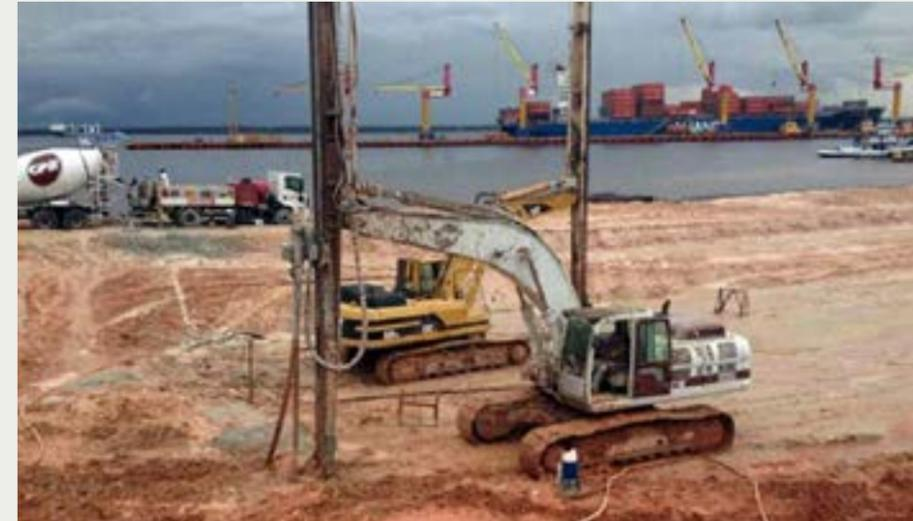
Figura 9 - Trabalhos de pré-furo, com ar comprimido, até a profundidade de 30m, seguido da posterior formação de bulbos de compressão do solo de modo a georrijecê-lo.
