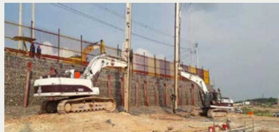
Figura 14 - Serviços de geoenrijecimento na praia, na ampliação da área portuária de Manaus, após os trabalhos de melhoramento do solo na região superior do cais motivado pelas rupturas.
