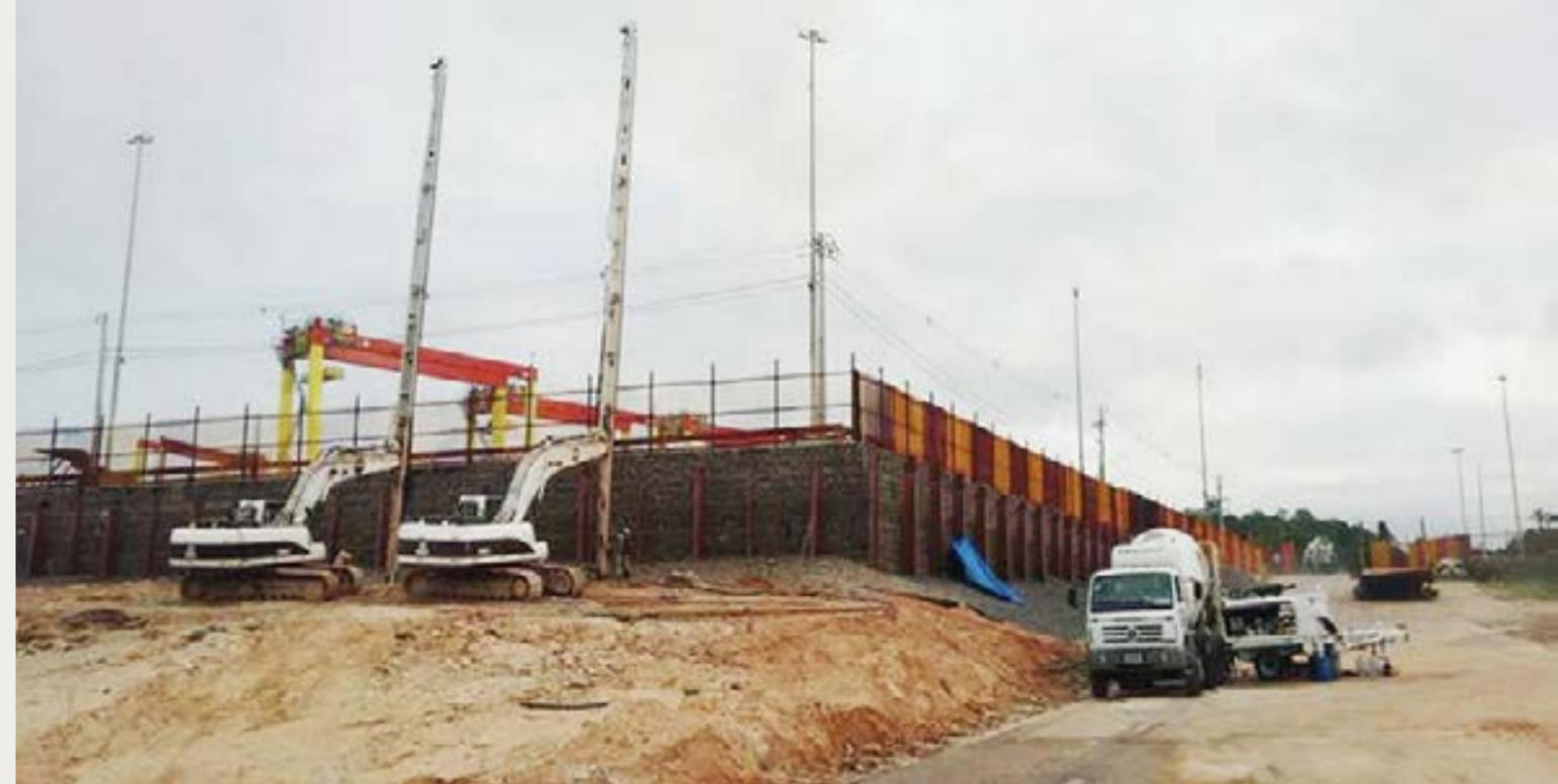
Figura 18 - Geoenrijecimento do solo objetivando as obras de ampliação.
