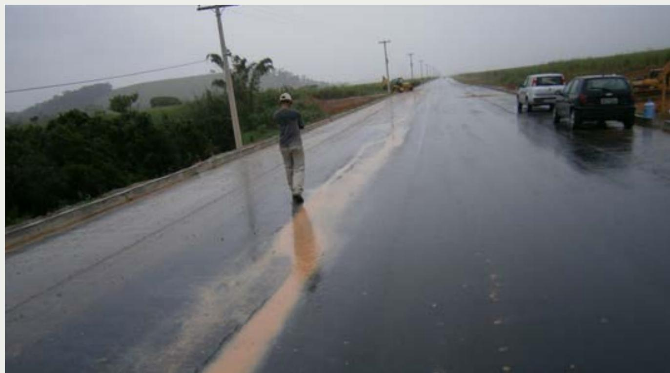
Figura 8 - Trincas longitudinais ao longo da rodovia demarcando a linha divisória entre o novo e o antigo aterro: diferenças de rigidez nos dois maciços aliado a ausência de escalonamento no antigo talude.
