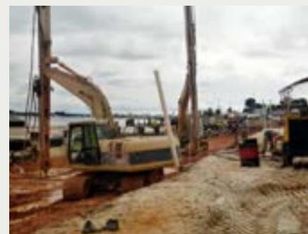
Figura 17 - Serviços de geoenrijecimento do solo próximo às áreas afetadas pelas rupturas ocorridas.
