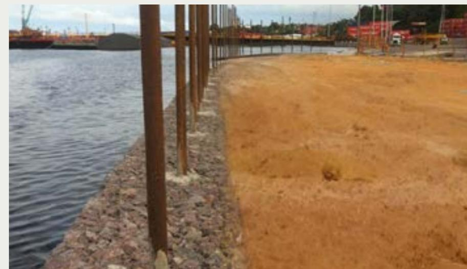
Figura 11 - Extenso cais portuário retificado pelo georrijecimento do solo de fundação, com muro gabião com cerca de 8m de altura, definindo o novo cais. Notar que o nível do rio está em sua cota máxima e o aterro apenas aguardando a base granular para assentamento do piso intertravado.
