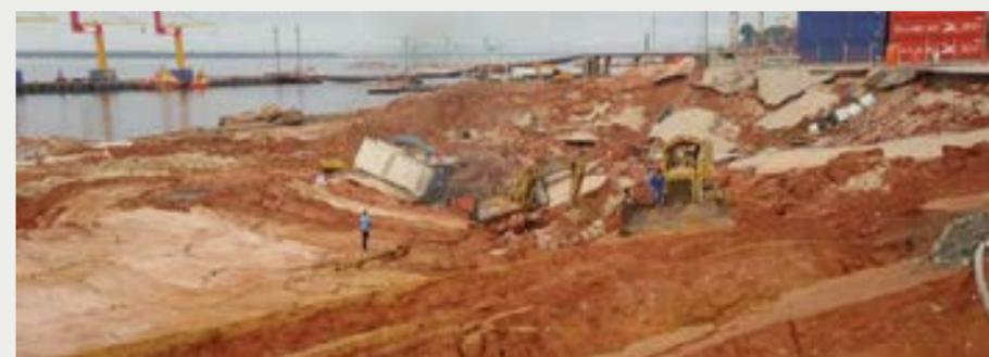
Figura 4 - Situação de ruptura típica da região portuária de Manaus.
