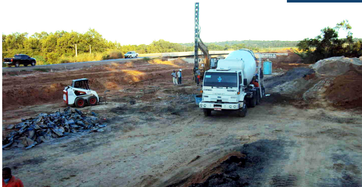
Após a remoção do aterro rompido, iniciou-se o geoenrijecimento
