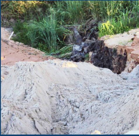
Outra rutura, provocou movimentação lateral da massa de solo, bloqueando parcialmente o Rio Curimataú.
