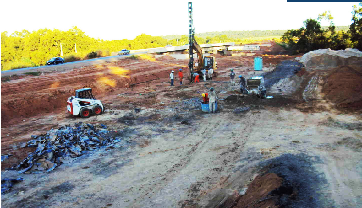
Visão panorâmica da região, com rio ao fundo, promovendo-se o geoenrijecimento do solo mole.
