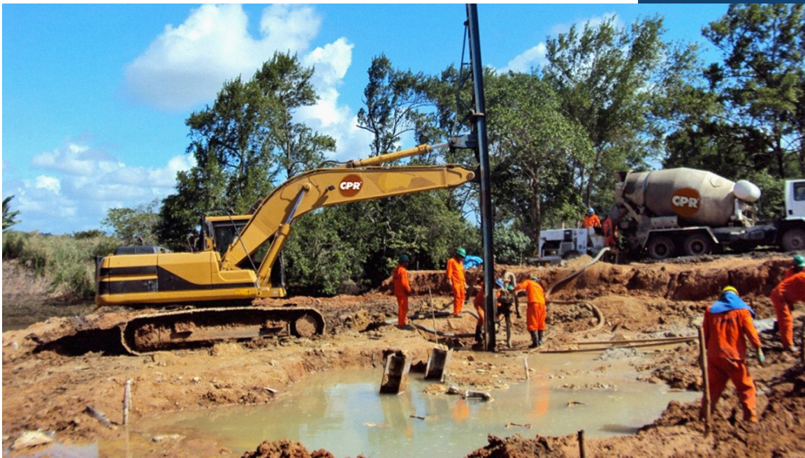
Após o corte da infraestrutura, comprometida, (visualizando-se as antigas estacas), e a remoção do aterro, iniciou-se o geoenrijecimento
