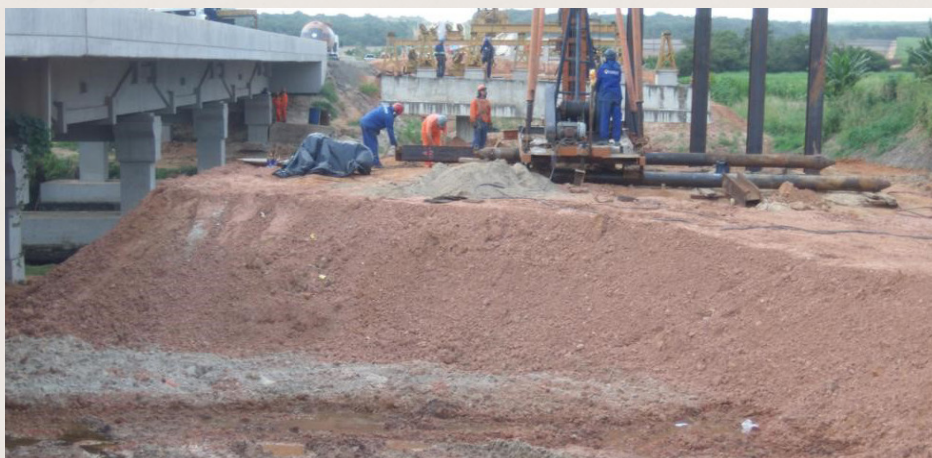
Elevação de aterro após o melhoramento do solo, com geoenrijecimento. Este encontro de ponte apresentava histórico de ruturas profundas que quase danificaram a antiga BR-101.
