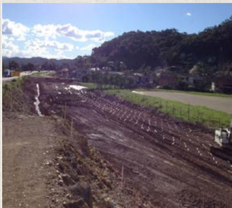
O estágio inicial do melhoramento do solo mole, iniciando-se a cravação de geodrenos, que possibilita a drenagem da argila saturada.
