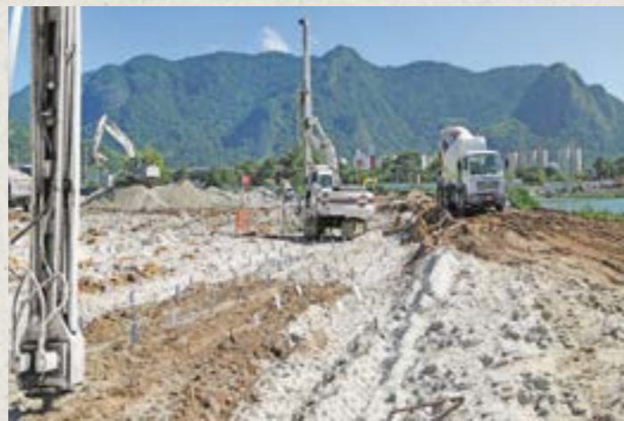
Melhoramento do solo mole no Rio de Janeiro, utilizando-se SD.
