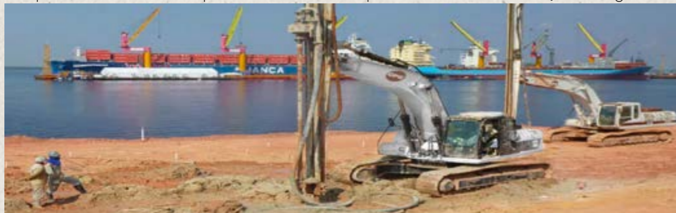
Melhoramento de solos moles, em Manaus, AM, com utilização de SD.
