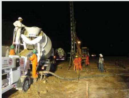
Figura 11 - O geoenrijecimento na região da primeira ruptura.
