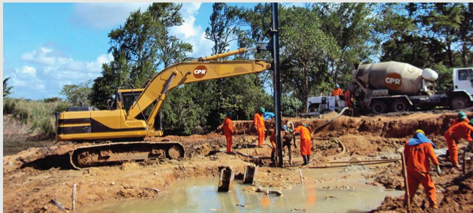
Figura 13 - O geoenrijecimento na região da segunda ruptura.
