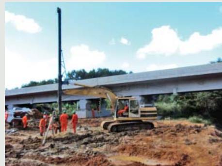
Figura 12 - O geoenrijecimento na região da segunda ruptura.
