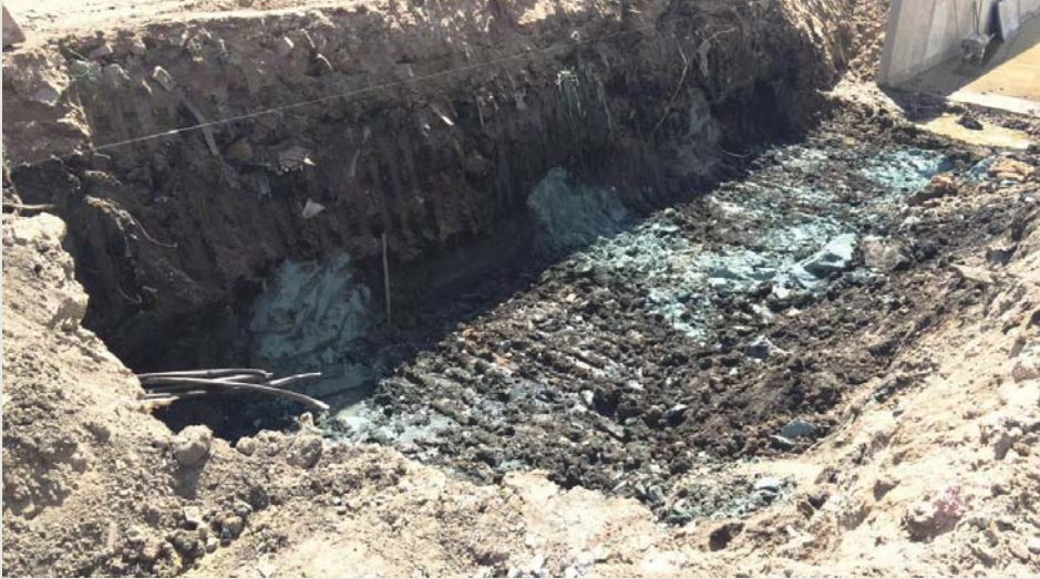
Figura 6 - Após o geoenrijecimento, com o processo de compressão radial imposto, pela expansão de cavidades, a matéria orgânica fica confinada e adensada.
