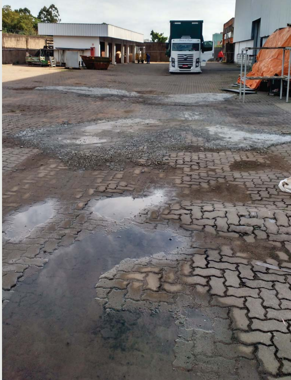
Figura 4 - Áreas de empreendimentos logísticos, rotineiramente, apresentam solos moles e a presença de matéria orgânica e turfa que, mais cedo ou mais tarde, promovem recalques...
