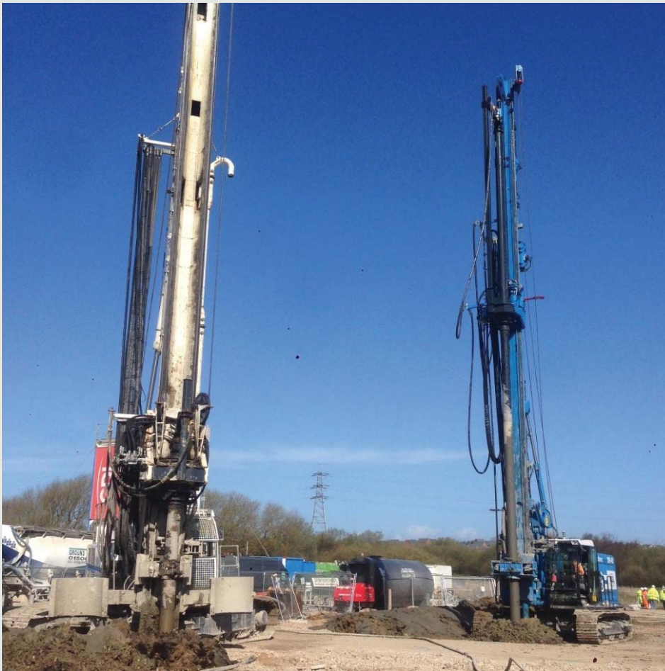
Figura 3 - Colunas com mistura do solo (DSM) é uma técnica de georeforço, que pode ser usada para melhorar as propriedades do solo, como um todo.
