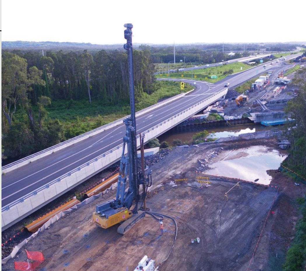
Figura 2 - Sistema de melhoria de solos moles à base de colunas com mistura do solo (DSM): os espaços entre colunas, onde permanece o solo mole, pode apresentar recalques.
