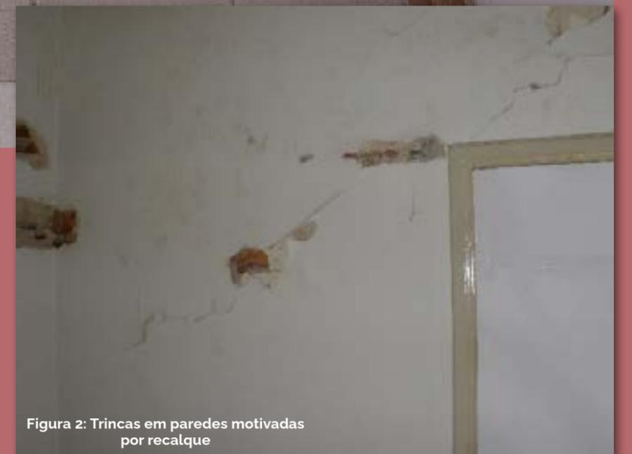
Figura 2: Trincas em paredes motivadas por recalque
