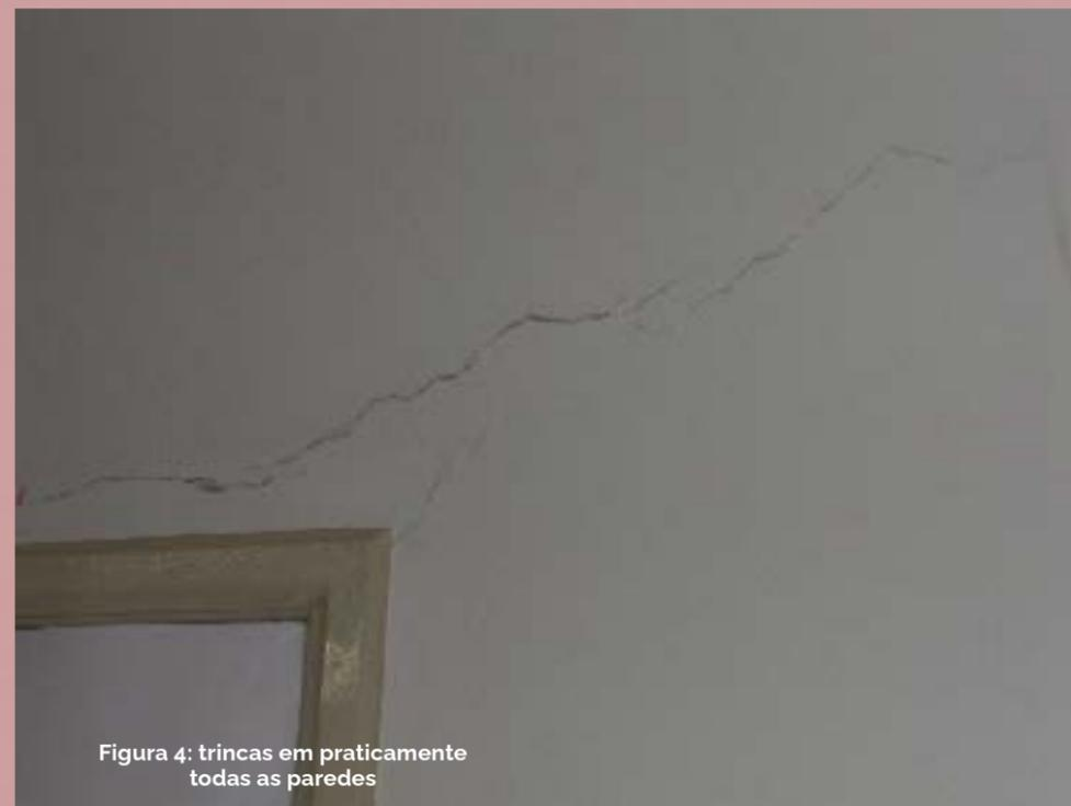
Figura 4: trincas em praticamente todas as paredes
