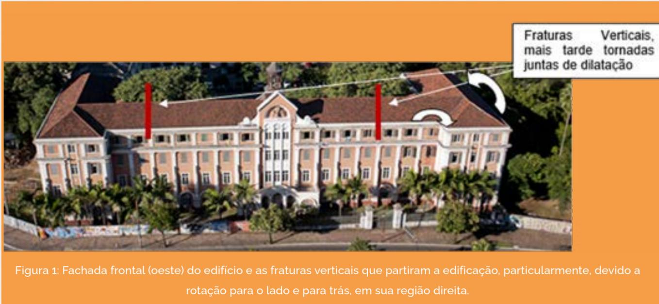
Figura 1: Fachada frontal (oeste) do edifício e as fraturas verticais que partiram a edificação, particularmente, devido a rotação para o lado e para trás, em sua região direita.
