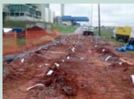
Figura 7: Malha de Geodrenos necessária à liberação da água e gases presentes no interior do solo, à medida em que se formavam os bulbos de compressão radial no solo, objetivando seu adensamento.
