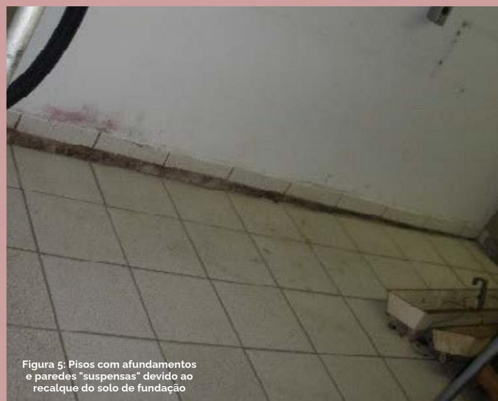
Figura 5: Pisos com afundamentos e paredes "suspensas" devido ao recalque do solo de fundação
