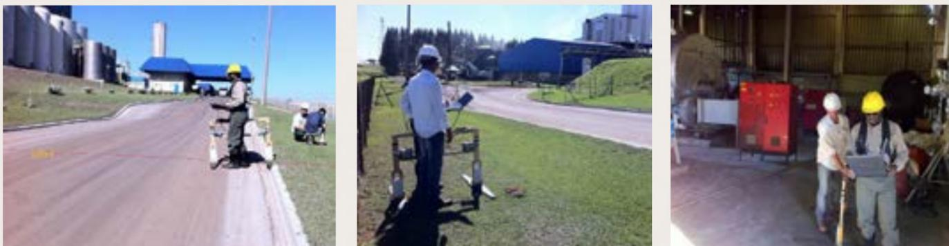
Figuras 3,4 e 5: levantamento de possíveis tubulações enterradas nas regiões a serem trabalhadas.
