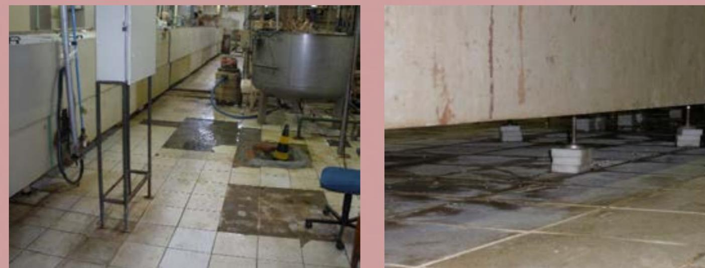
Figura 8: Desníveis nos pisos, no setor de caldeiras, com deslocamento do revestimento e formação de vazios sob as paredes e sob os equipamentos que, constantemente, eram renivelados com plaquetas.
