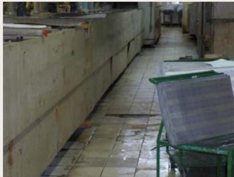
Figura 7: Equipamentos extensos apoiados sobre plaquetas para possibilitar seu nivelamento, provocado por afundamentos nos pisos.
