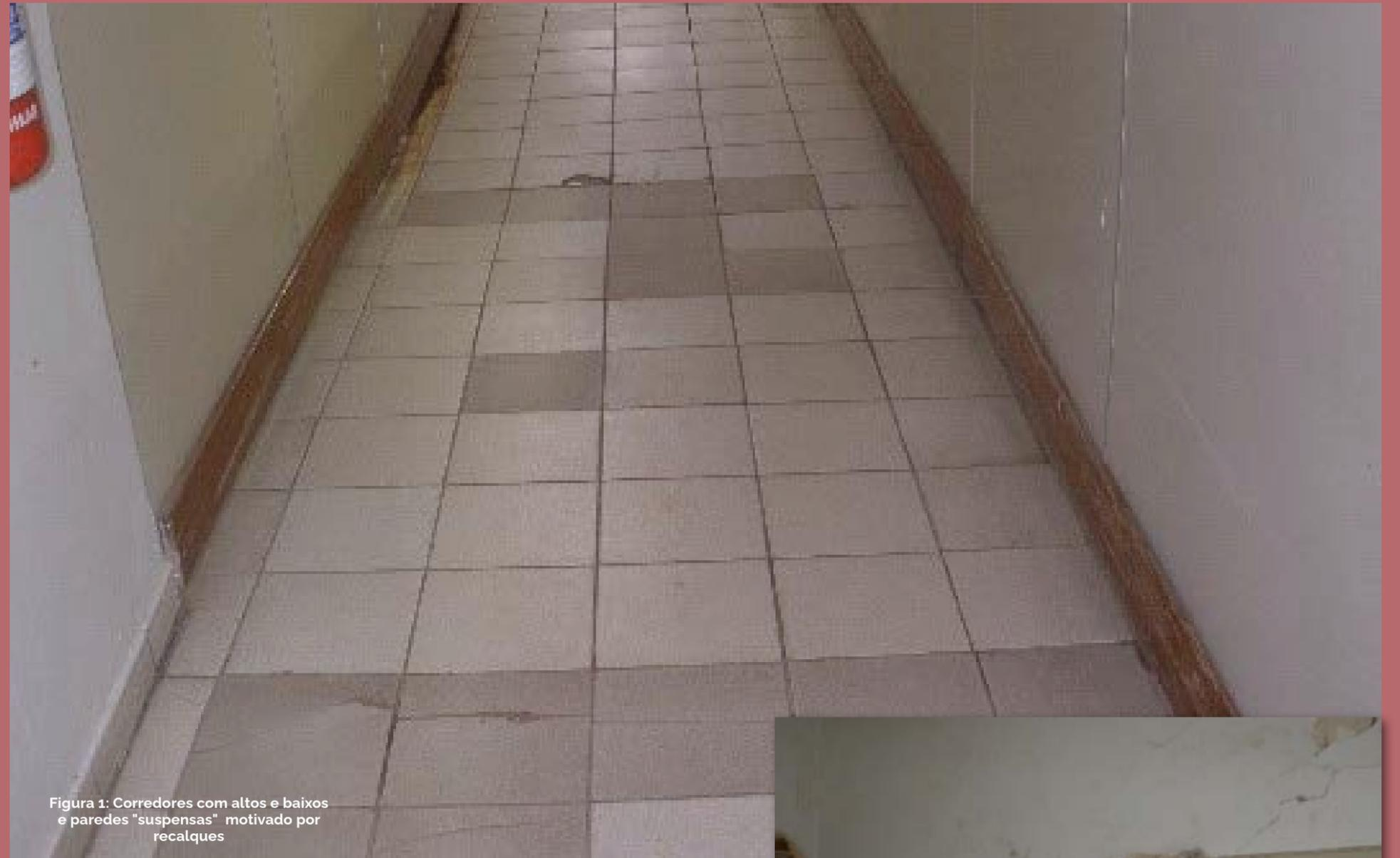
Figura 1: Corredores com altos e baixos e paredes "suspensas" motivado por recalques
