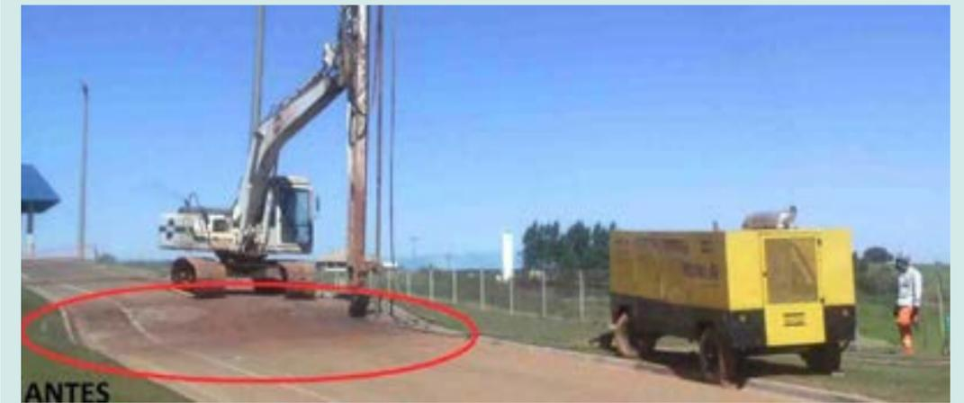
Figura 13: O pavimento de acesso à área biodiesel apresentava intensa deformação em decorrência de processo de recalque no local. O geoenrijecimento foi executado, estabilizando-se o solo de fundação, além de, dentro do possível, corrigidas as deformações no pavimento.
