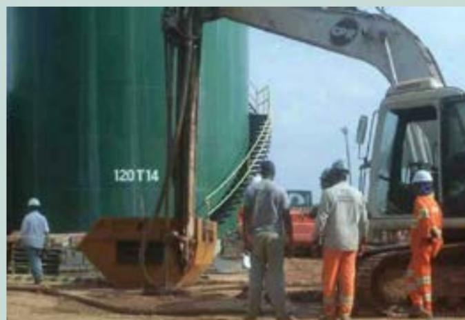
Figura 19: Melhoramento do solo em torno do tanque AE6
