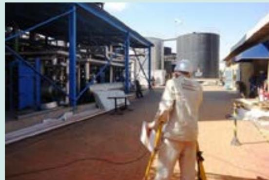
Figura 9 e 10 :Durante todo o serviço, havia monitoramento constante do piso, de modo a, se possível, corrigi-lo com levantamento, já que apresentava afundamentos.
