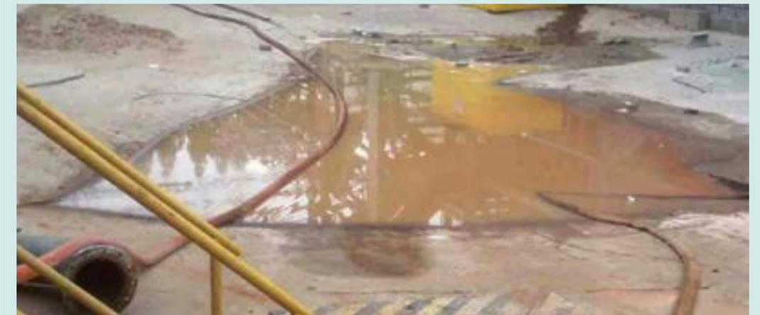
Figura 14: Área 05 antes do melhoramento: um sério processo de afundamento do pavimento, que ultrapassava os 100 cm.
