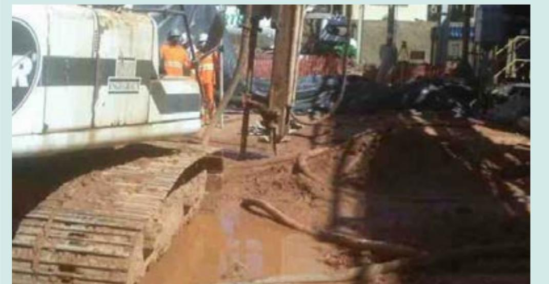
Figura 15: Área 05 antes do melhoramento: um sério processo de afundamento do pavimento.
