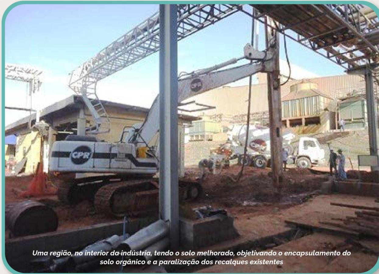
Uma região, no interior da indústria, tendo o solo melhorado, objetivando o encapsulamento do solo orgânico e a paralização dos recalques existentes
