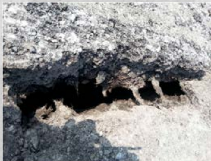
Fig 6 - Cavidades após a remoção do pavimento.
