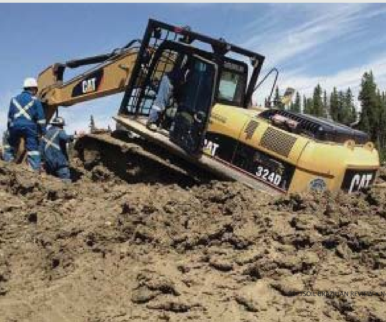
Figura 3 - Dificuldades de trabalho em terrenos com solos moles.
