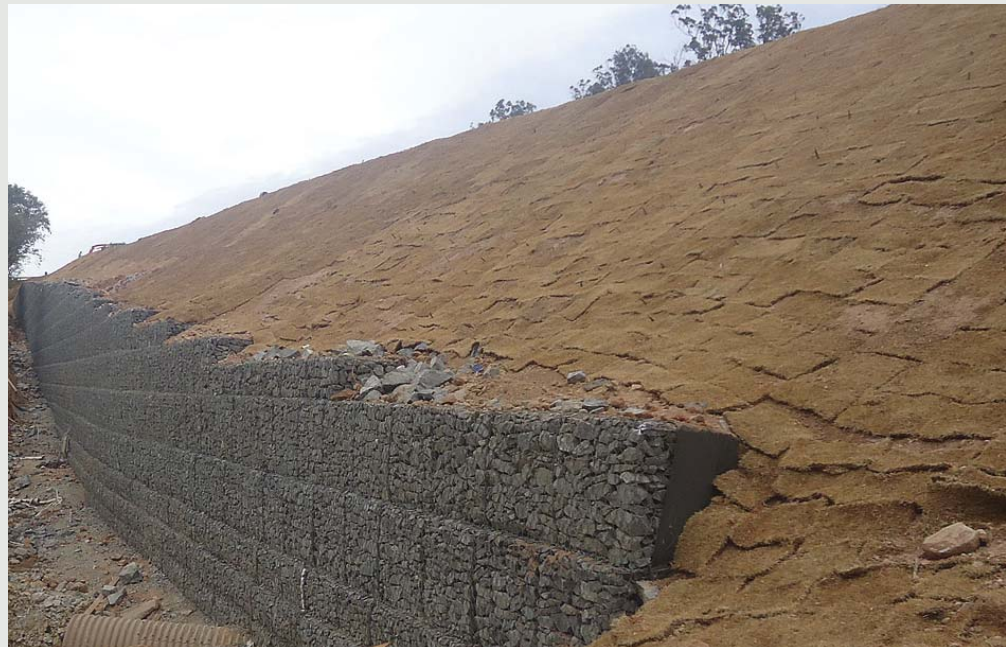
Figura 13 - No limite com o vizinho, eleva-se um muro em terramesh com 6m de altura sobre o gasoduto, onde apresenta-se a berma no meio do vão do talude. A partir desta berma, eleva-se o talude até a nova rodovia.
