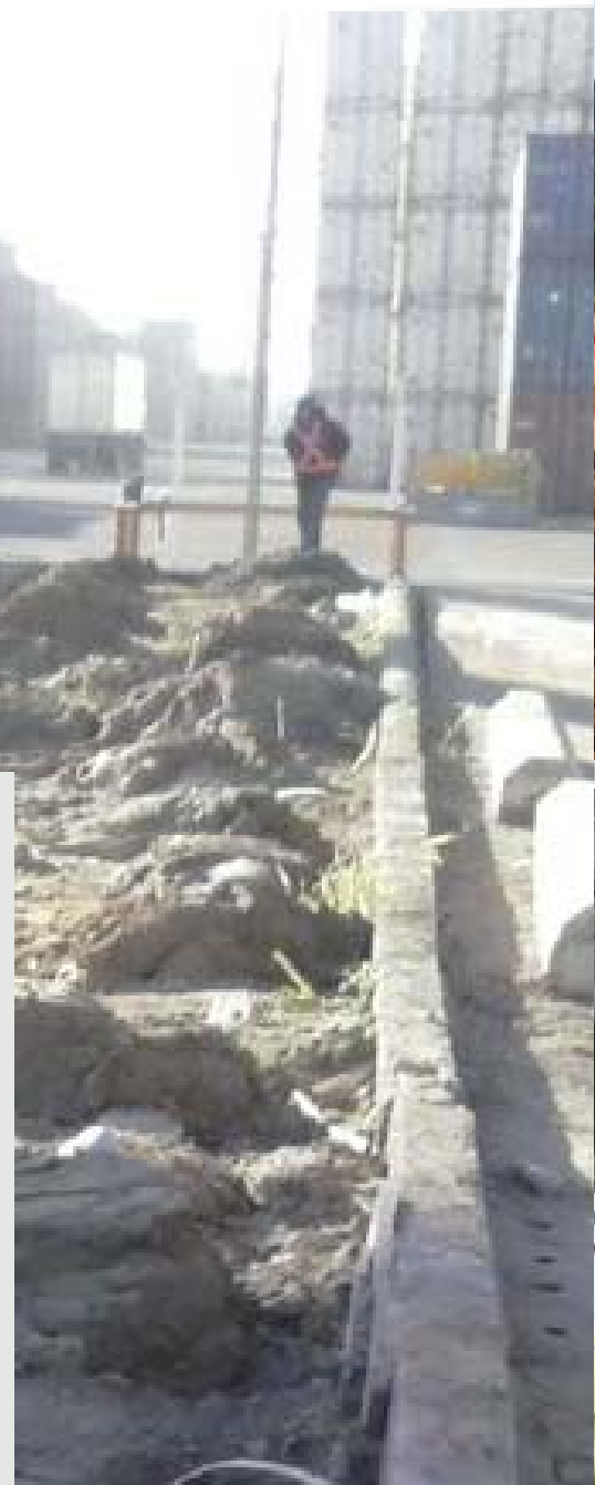
Figura 9 - Formação das duas linhas de verticais de Geoenrijecimento do solo pertinente ao 1º “muro” de reforço do solo, totalizando 99 verticais que consumiram 91 caminhões betoneira de geogROUT de 8m³ cada, ou seja, praticamente um caminhão por vertical.
