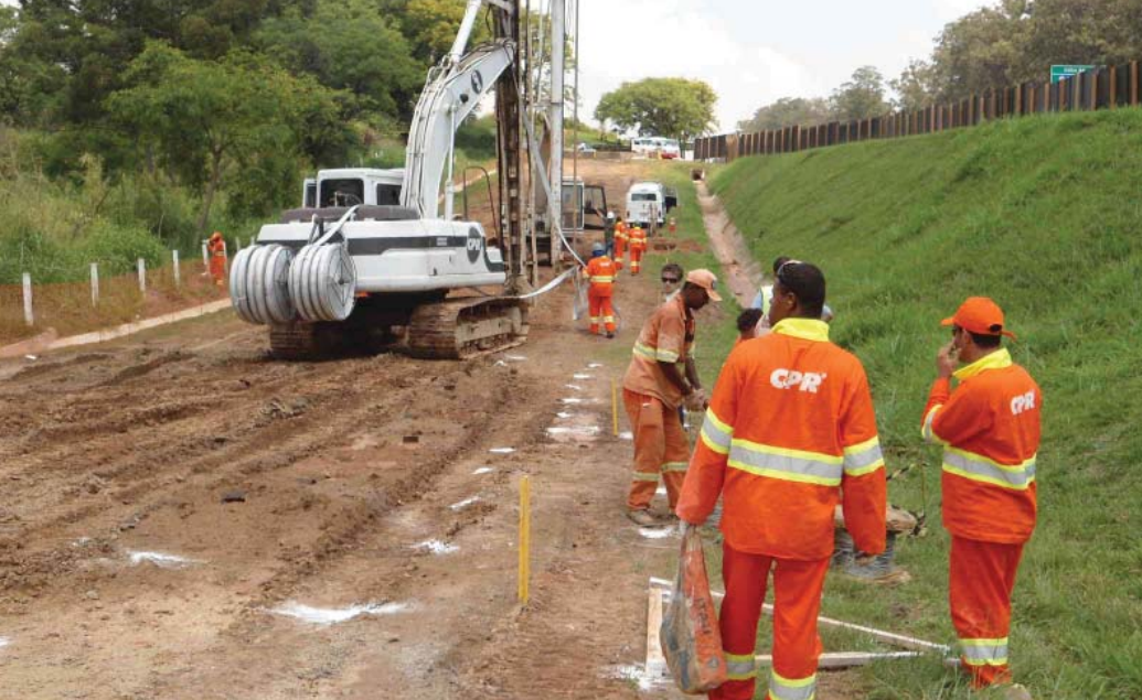
Figura 5 - Cravação de geodrenos para a execução do geoenrijecimento em uma marginal da Anhanguera.
