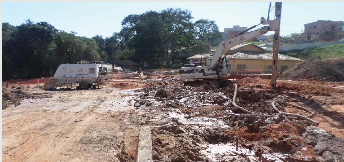
Figura 11 - Melhoramento de solos moles com Geoenrijecimento para construção de rodovia no Contorno de São Roque para acesso à Raposo Tavares, em São Roque, SP.
