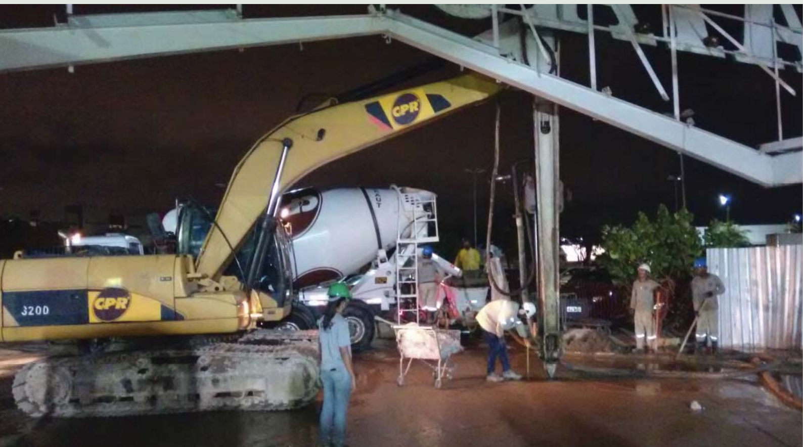
Figura 7 - Processo de geoenrijecimento do solo com a formação de bulbos de geogROUT para formação de verticais de modificação do solo tendo, cada uma, diâmetro aproximado de 1,10m, a partir da cota -12m.
