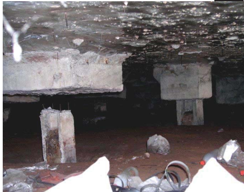
Figura 3 - A execução de espessos aterros sobre depósitos de solos moles promove o atrito negativo.
