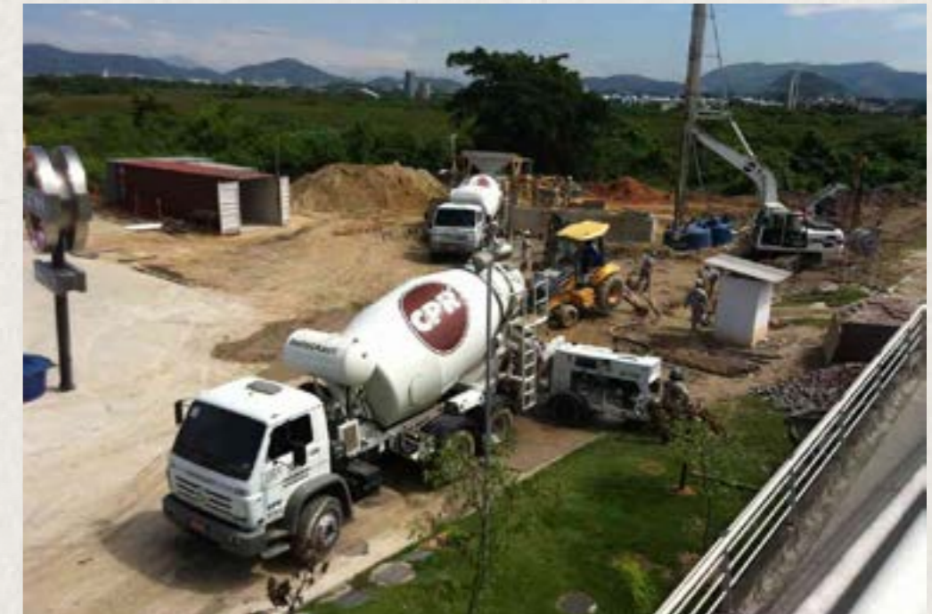
Melhoramento do solo mole para duplicação de rodovia no Rio de Janeiro.
