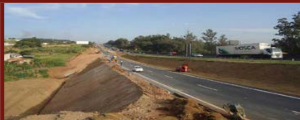
Uma das marginais, à Anhanguera, pronta, observando-se o grande talude terminado (pé) em cima do muro gabião, já na faixa de domínio, que coincide com o duto de gás.
