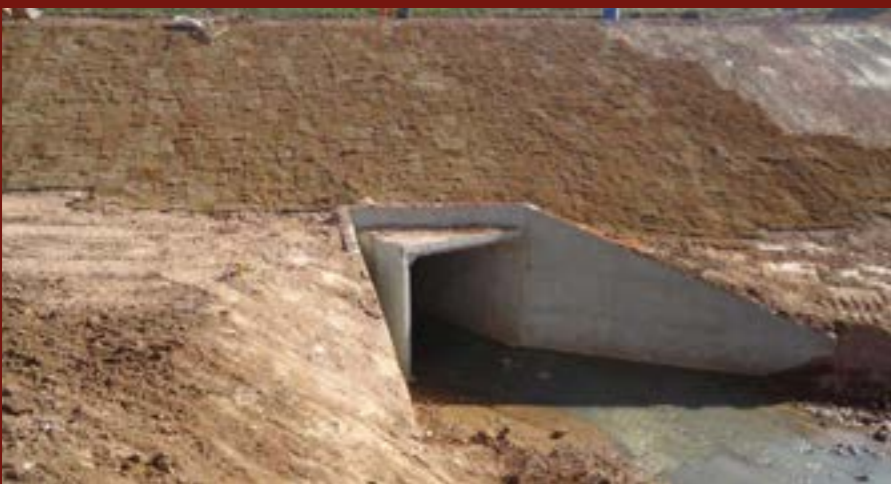
O melhoramento do solo já executado, assim como 12m de aterro sobrepostos, incluindo o leito do riacho, que recebeu novas galerias.
