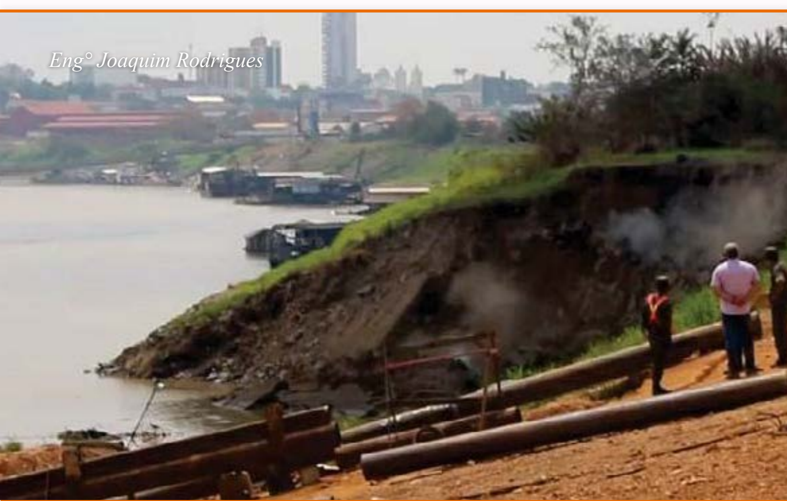
Figura 1: Deslizamento de terra ocorrido às margens do Madeira, em Porto Velho, e a vistoria da Defesa Civil. 15 caminhões tanque, uma caminhonete e uma moto foram arrastados pelo rio, após o barranco onde funcionava um posto de carga, ceder.
