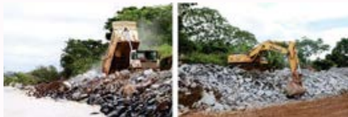
Figura 16: Trabalhos de enrocamento ao longo dos rios amazônicos são rotineiramente perdidos.
