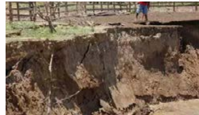
Figura 5: Comunidade em Santarém afetada pelo fenômeno das terras caídas
