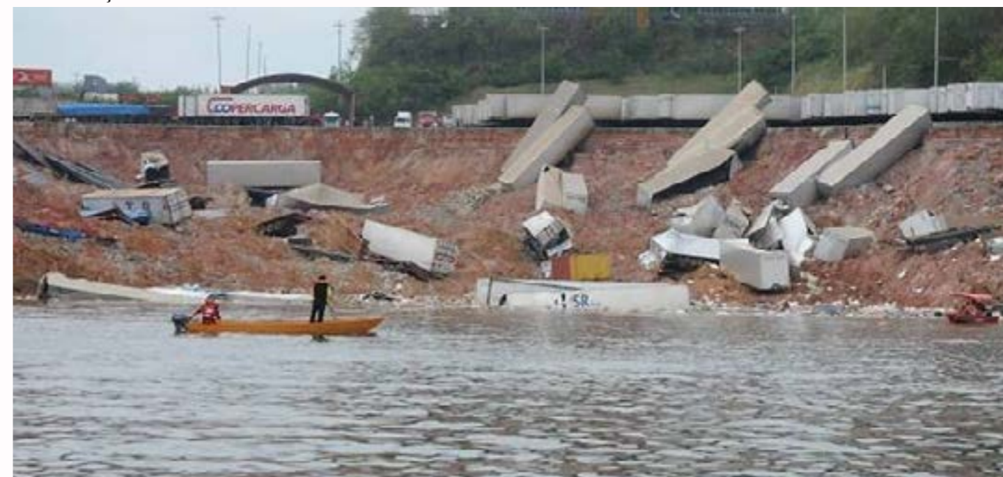
Figura 4: Faixa de aproximadamente 40 metros de largura da margem caída em área portuária fluvial.
