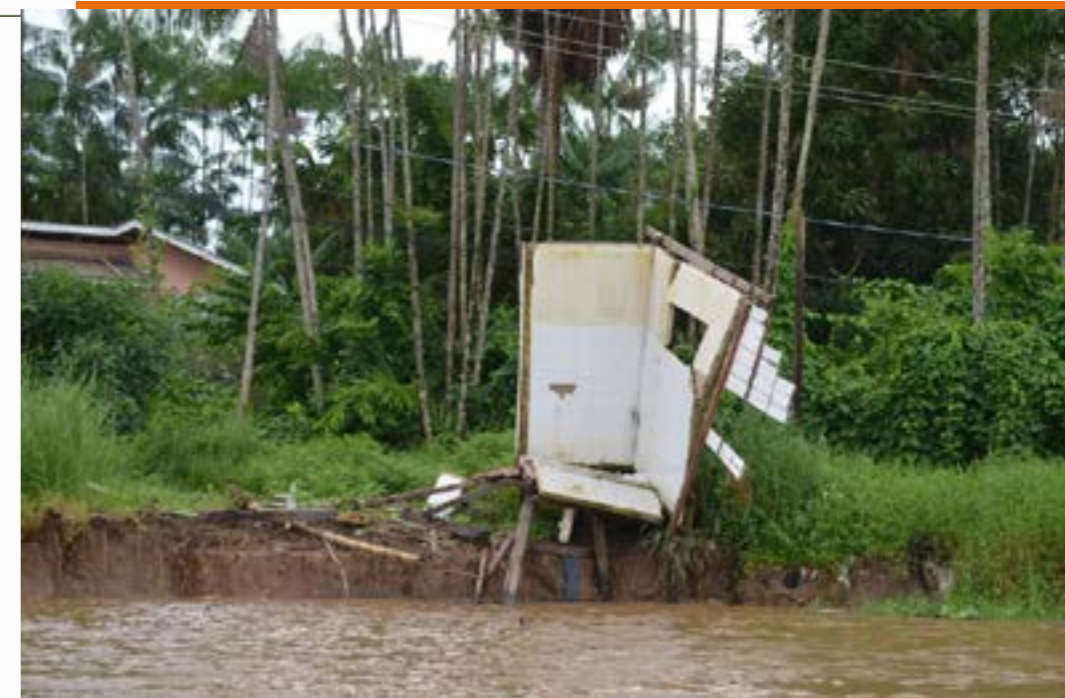
Figura 3: Fenômeno das 'terras caídas' no arquipélago Bailique, no Estado do Amapá
