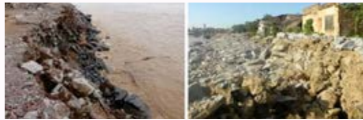
Figura 17: Enrocamentos e o natural processo de erosão com cedência, em razão da ausência de capacidade suporte do solo de fundação e ação do rio.
