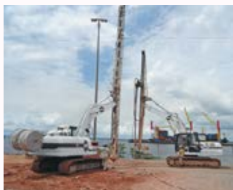
Figura 18: O melhoramento do solo em Tocantins, com a modificação dos parâmetros de resistência e rigidez dos taludes fluviais, permitem a construção de estruturas de contenção.
