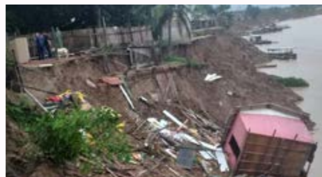
Figura 2: Situação de emergência após agravamento do fenômeno 'terras caídas' no Acre.
