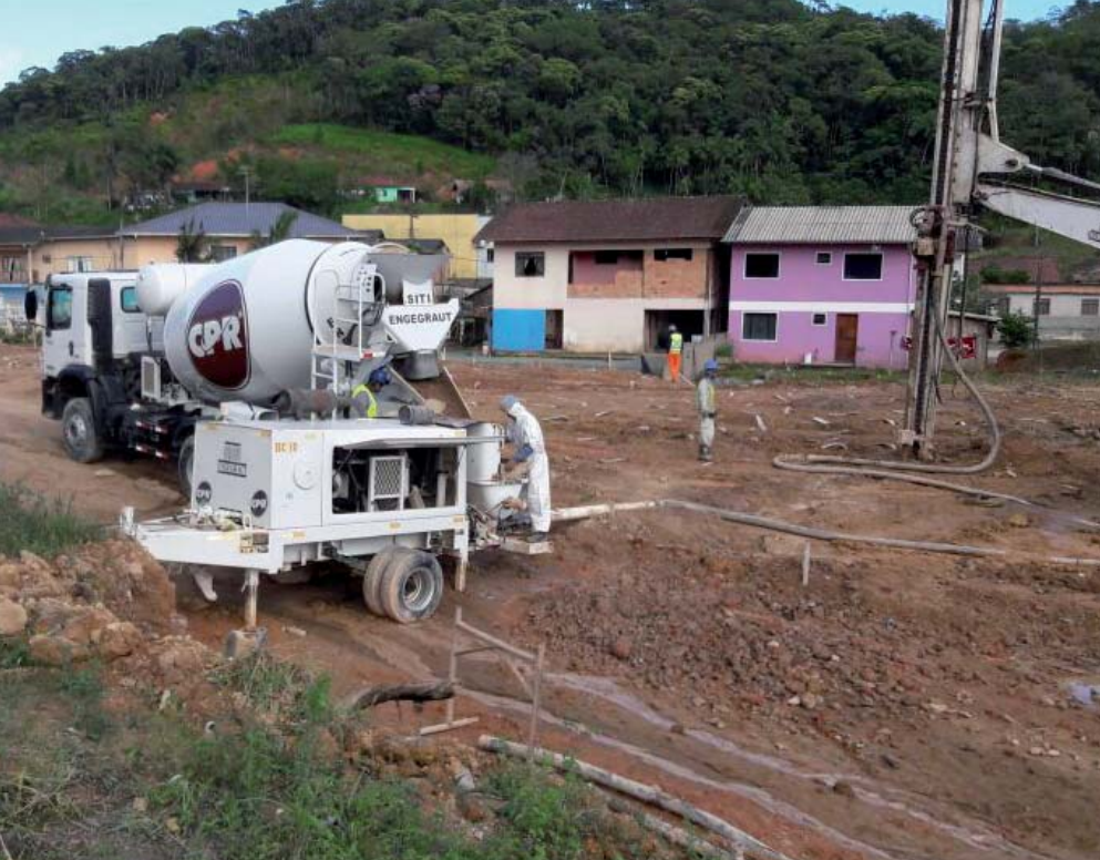
Figura 9 - Repare os geodrenos cravados no terreno para dissipar a poropressão gerada durante o Geoenrijecimento do solo mole.
