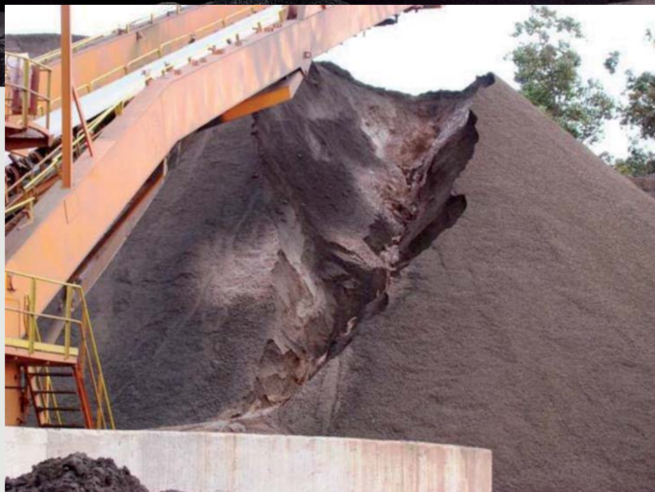
Figura 2 - Rutura de pilha de minério no porto de Vitória, ES. (Evandro Moraes Gama).
