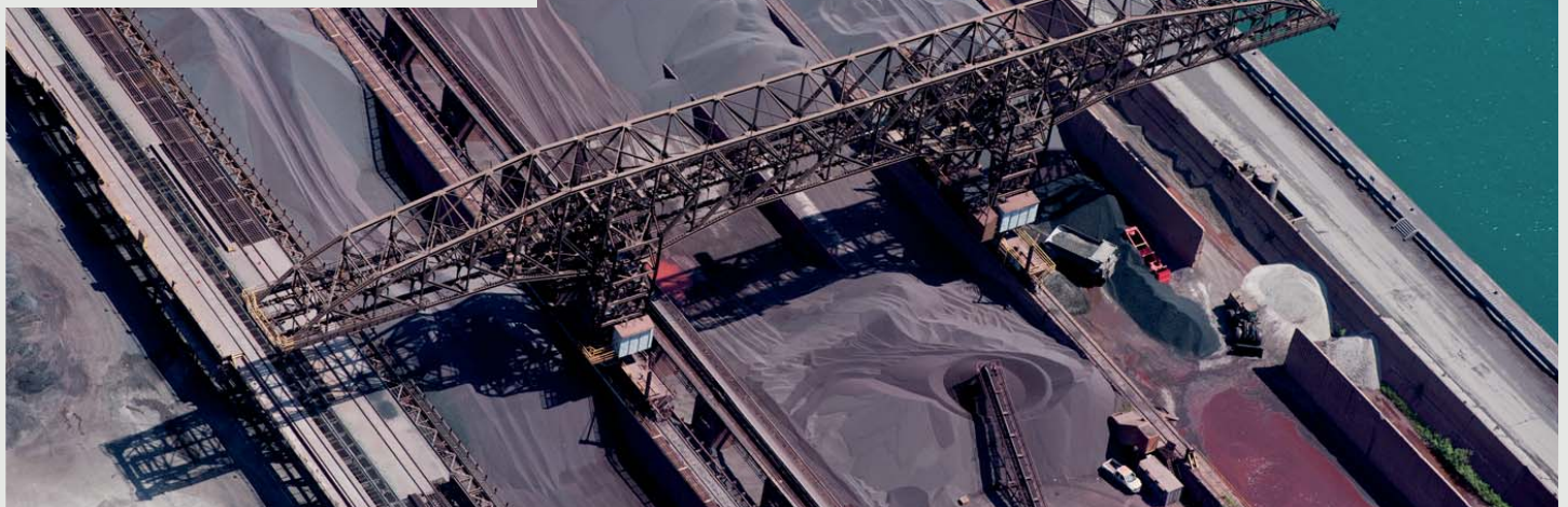
Figura 9 - O melhoramento do solo de fundação, homogeneizando-o com parâmetros que atendam aos critérios de estabilidade e deformação, é a melhor estratégia para evitar riscos e prejuízos nas áreas de trabalho.
