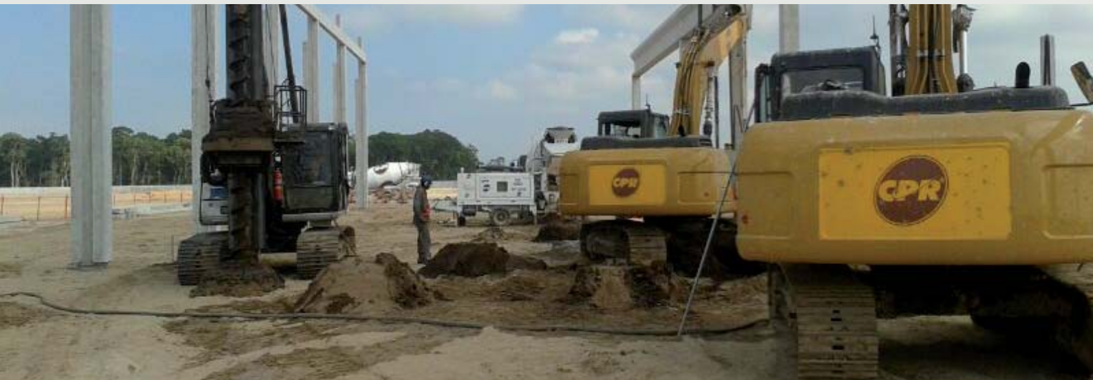
Figura 2 - A execução de pré-furos para o início do processo de Geoenrijecimento do solo mole para fabricação de uma fábrica de carros no sul do país.
