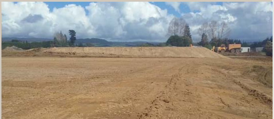
Situação típica de um aterro de pré-carregamento onde, na maioria das vezes, não é consebido e realizado de forma adequada. Trata-se de uma solução barata, mas muito limitada e muito pouco eficiente.
