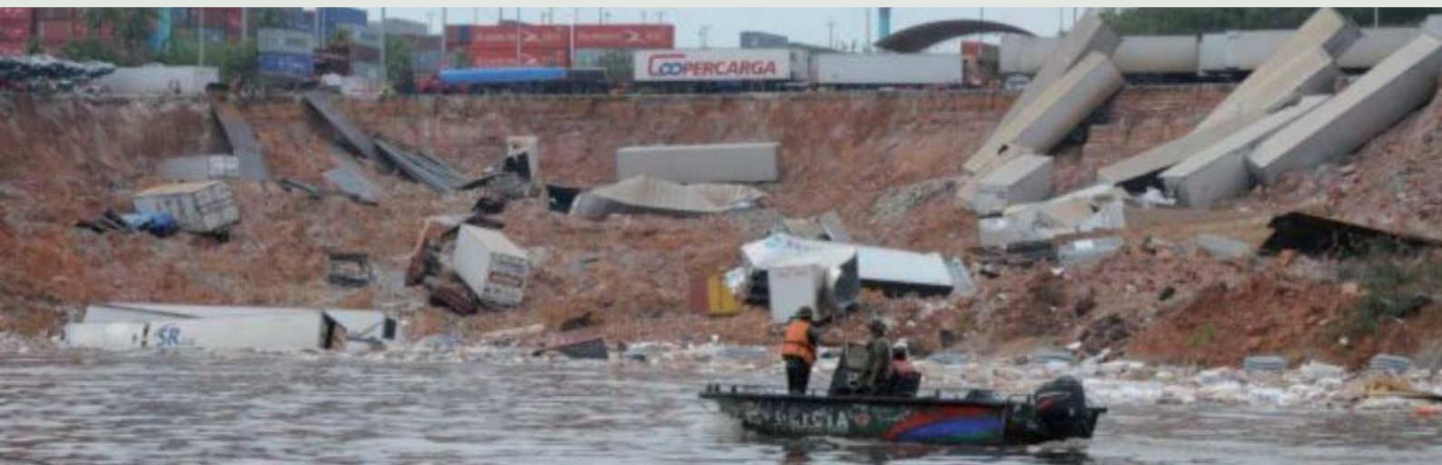
Figura 5 - Rutura da margem portuária de Manaus, devido a permanência do excesso de poropressão nos aterros, seguido do rápido esvaziamento do Rio Negro. Todo o solo de fundação, da margem portuária, após este acidente em 2010, foi Geoenrijecida, promovendo a estabilidade necessária (resistência), impedindo a formação de novos picos de poropressão, ao mesmo tempo em que aumentou-se a rigidez do solo de fundação pela homogeneização de toda a massa de solo.
