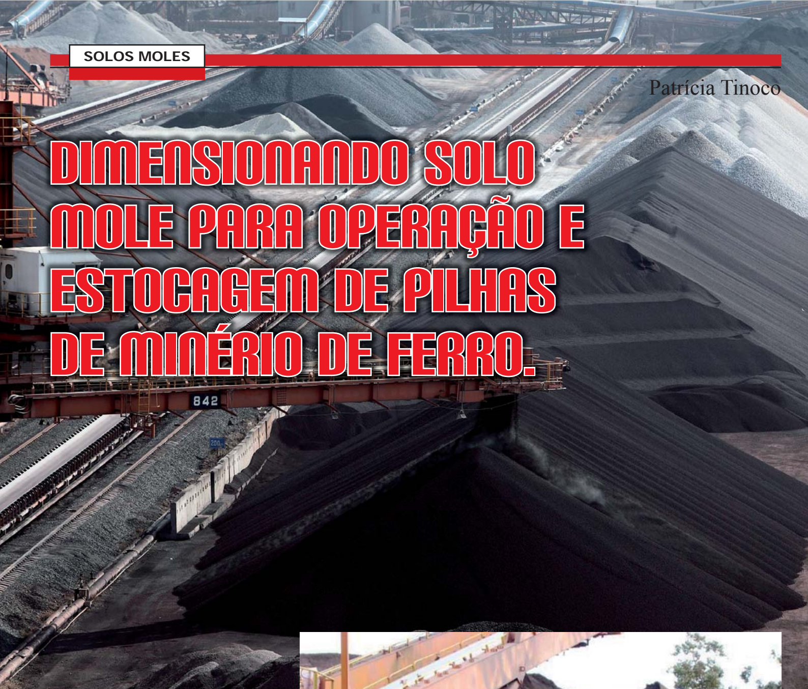
Figura 1 - Pilhas de minério tensionam exageradamente o solo de fundação.
