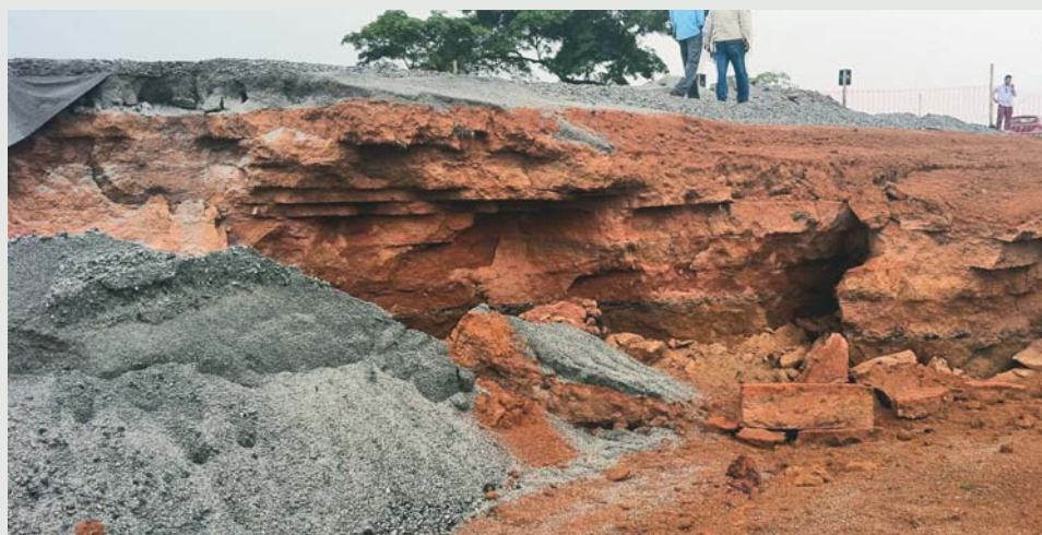
Figura 3 - Rutura, durante a tentativa de se fazer precarregamento, na ampliação de uma estrada no Rio de Janeiro. Repare que a rutura ocorreu exatamente nas laterais da antiga estrada, onde foi feito o aterro.
