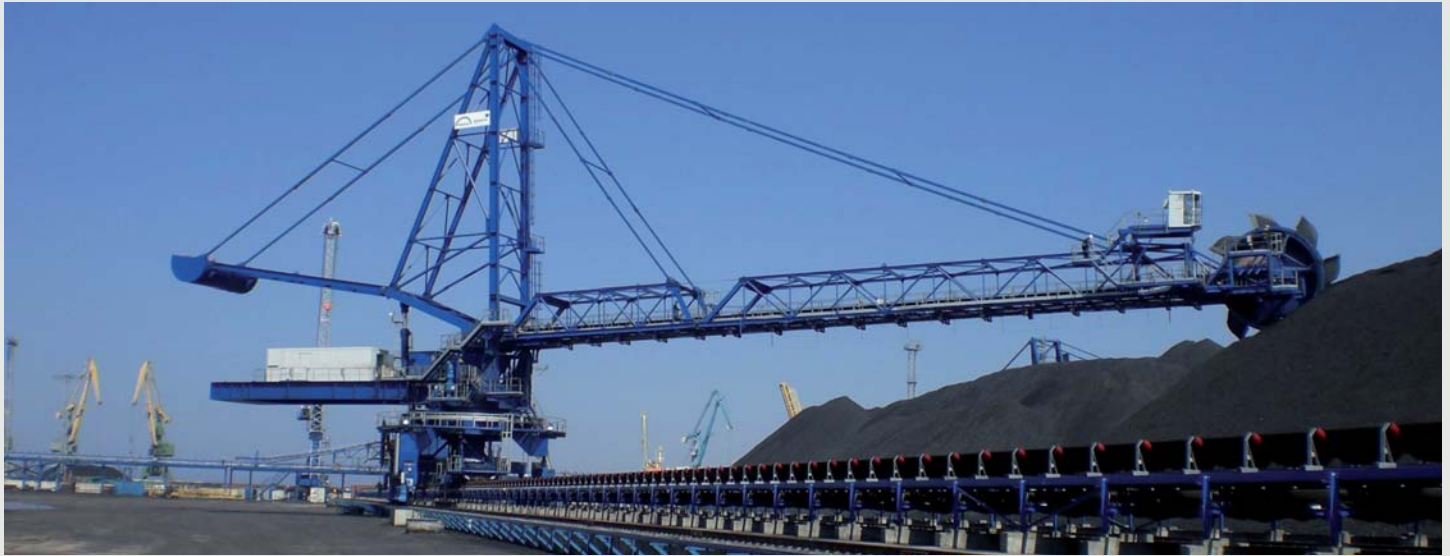
Figura 10 - Pilhas de minério causam deformações no solo de fundação. É necessário idealizar parâmetros adequados para o solo melhorado. Desta forma, evita-se riscos e prejuízos.
