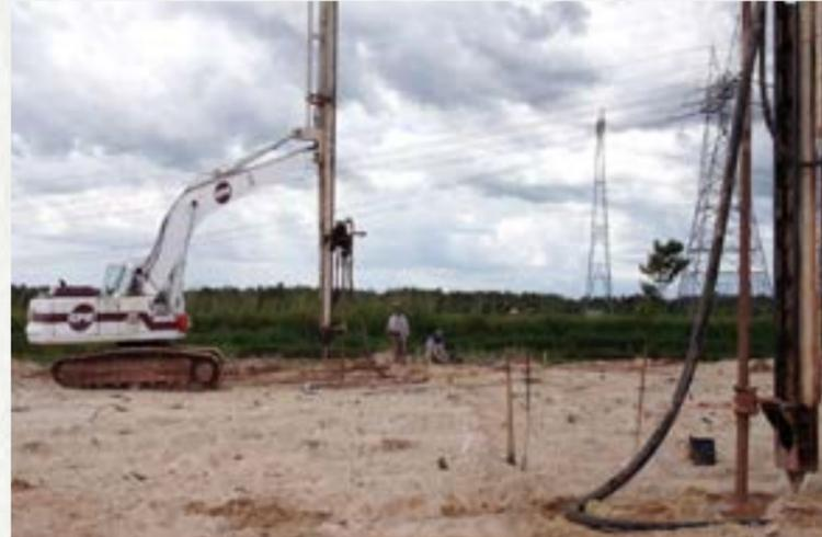
Figura 5: Os drenos são transformados em uma parede cilíndrica drenante
