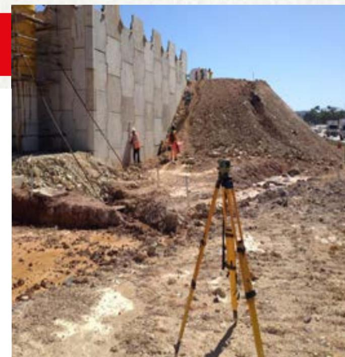
Figura 6: Elevação de aterro, em terra armada, após o melhoramento do solo mole, com geoenrijecimento.
