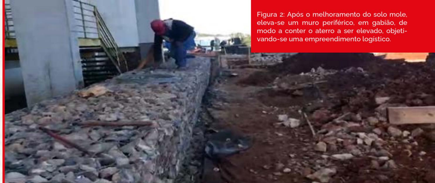
Figura 2: Após o melhoramento do solo mole, eleva-se um muro periférico, em gabião, de modo a conter o aterro a ser elevado, objetivando-se um empreendimento logístico.
