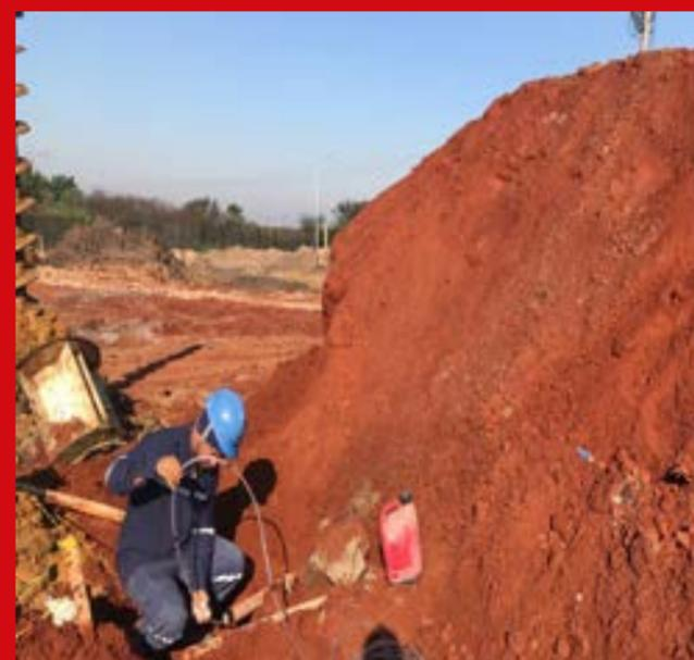
Figura 13: Instalação de perfilômetro, em um aterro teste, após o melhoramento do solo. Esta obra, com a presença de camada de solo mole/muito mole, irá receber aterro com 3m de altura mais as cargas do empreendimento.
