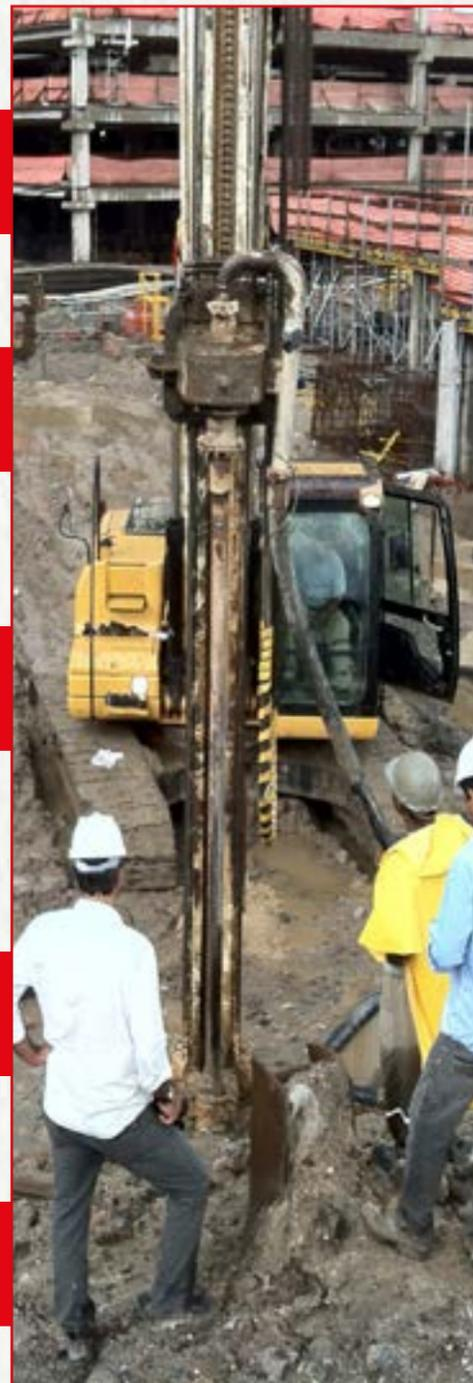
Figura 5: Formação dos bulbos de compressão radial durante o melhoramento do solo mole, objetivando-se escavação para um subsolo.
