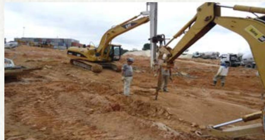
Figura 3: Solo de fundação, de área portuária, sendo melhorado para receber aterro e contêineres.
