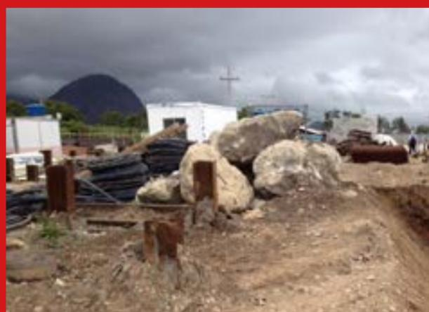
Figura 2 e 3: Bulbos de geogROUT após serviços de geoenrijecimento para viabilizar escavação para a construção de dois subsolos com a presença de solo mole.
