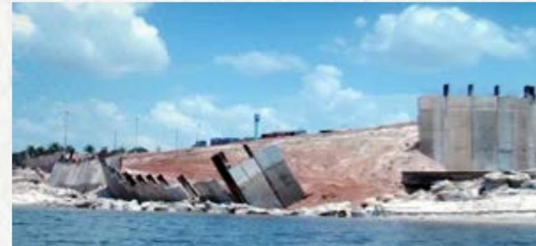
Figura 3: Destruição de orla portuária por liquefação. Repare que os sistemas de contenção com estacas metálicas e painéis de concreto armado não são suficientes para os altos empuxos laterais decorrentes do excesso de poropressão. A única solução é com melhoramento do solo utilizando-se o geoenrijecimento.
