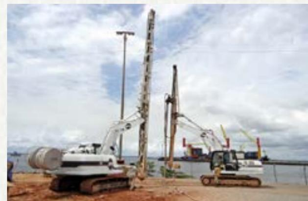
Figura 6: Melhoramento do solo junto ao cais portuário de modo a melhorar a condição de estabilidade.
