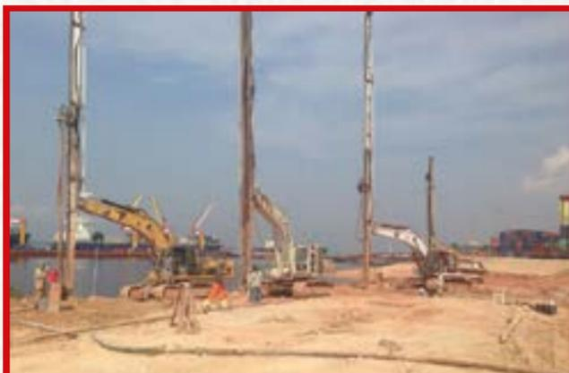
Figura 5: Melhoramento do solo junto ao cais portuário de modo a melhorar a condição de estabilidade.
