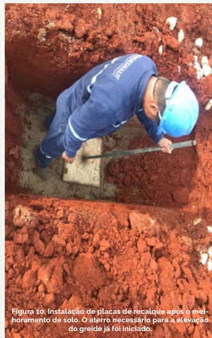
Figura 10: Instalação de placas de recalque após o melhoramento de solo. O aterro necessário para a elevação do greide já foi iniciado.
