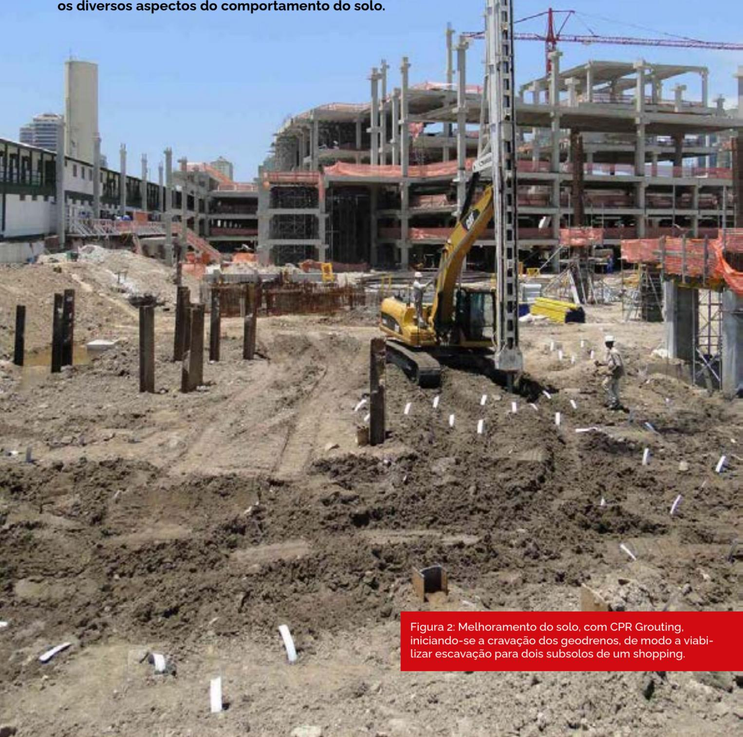
Figura 2: Melhoramento do solo, com CPR Grouting, iniciando-se a cravação dos geodrenos, de modo a viabilizar escavação para dois subsolos de um shopping.
