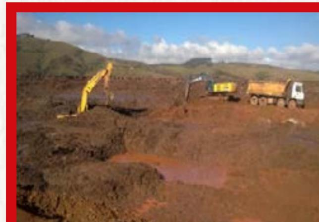
Figura 3: Em barragens de rejeito, para sua descaracterização, torna-se necessário melhorar o solo com georrijecimento, de modo a evitar instabilidades.
