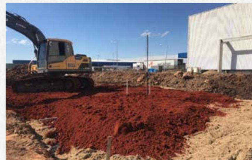
Figura 5: Após o melhoramento do solo mole, inicia-se a elevação do aterro para obtenção do greide de projeto.
