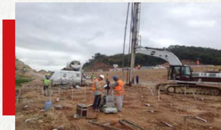
Figura 9: Melhoramento do solo, com geoenrijecimento e análise piezométrica certificando o serviço.
