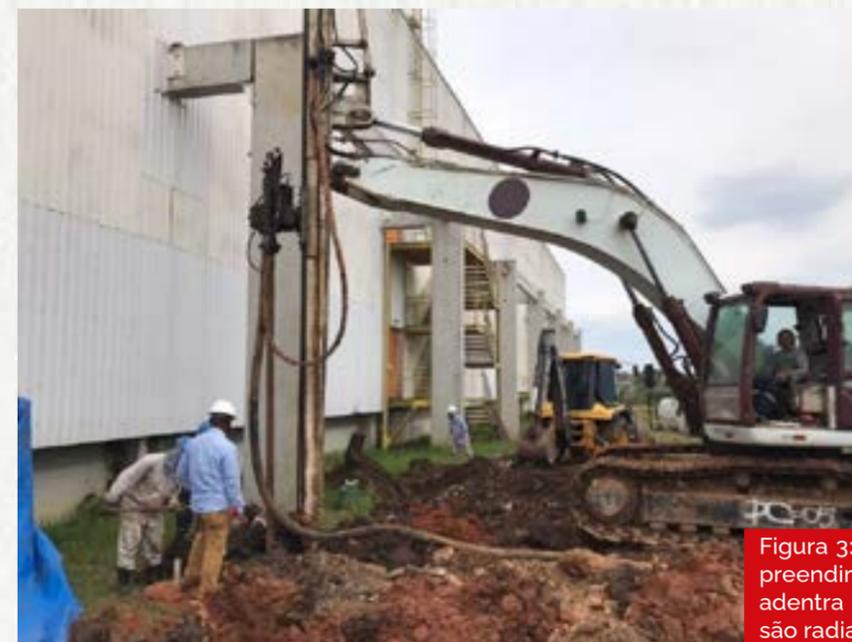
Figura 3: Melhoramento do solo, para ampliação de empreendimento logístico. Nesta etapa, nota-se o tubo que adentra no solo para formação dos bulbos de compressão radial.
