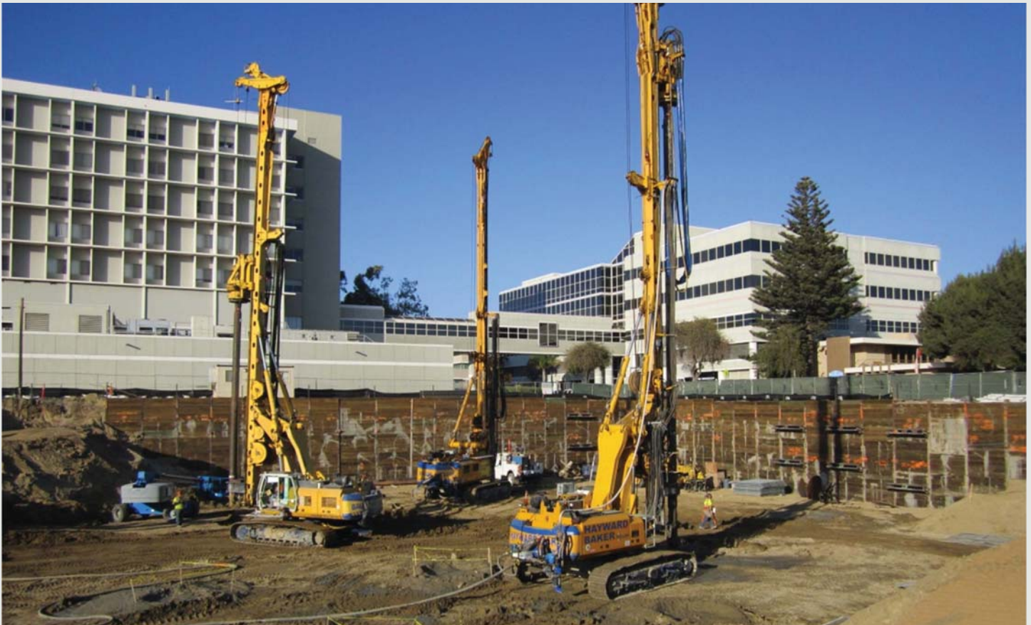
Figura 17 - 3 equipamentos de deep soil mixing em ação.
