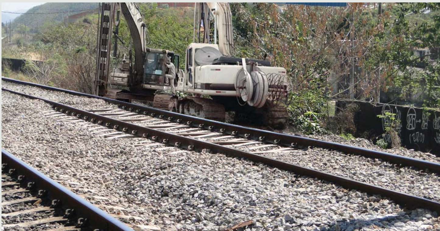
Figura 6 - A necessidade da execução de travessias, com Tunnel Liner, sob a ferrovia Central do Brasil, no Rio de Janeiro, exigiu o melhoramento do solo com Geoenrijecimento, utilizando Compaction Grouting.
