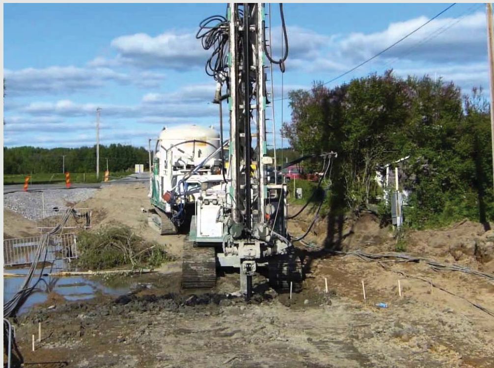
Figura 5 - Formação de colunas de solo-cimento no deep soil mixing.
