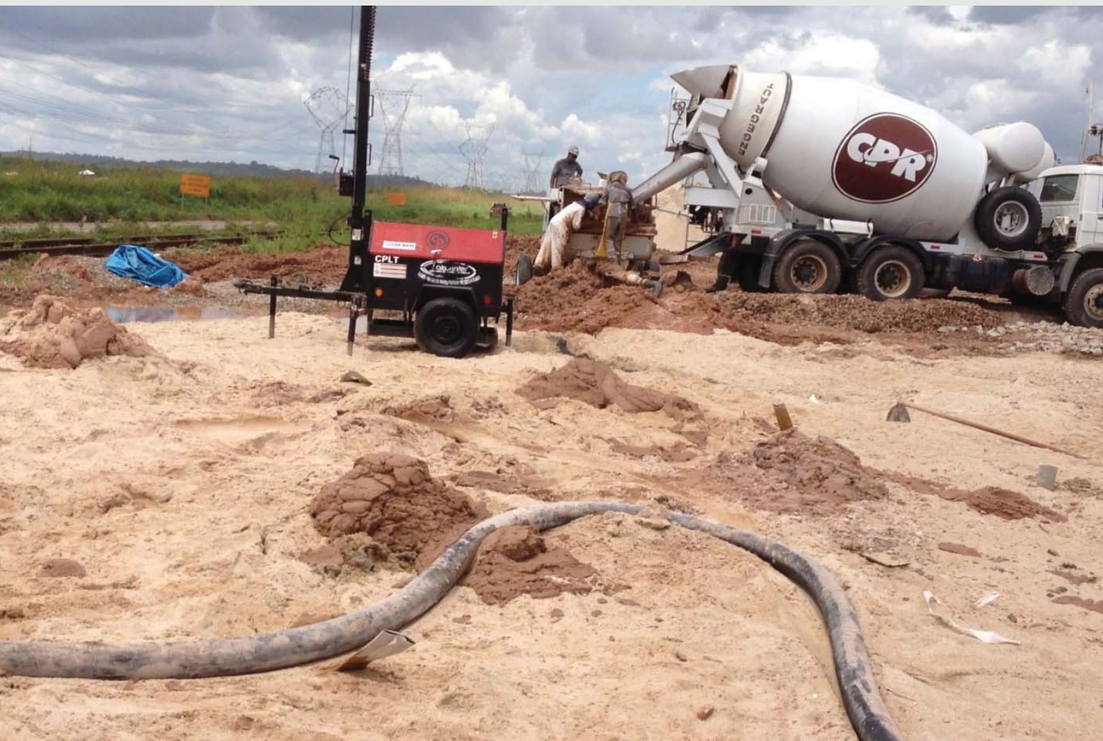
Figura 7 - Melhoria do solo de fundação, com presença de solos moles, utilizando-se o Geoenrijecimento com CPR Grouting junto a ferrovia Carajás.
