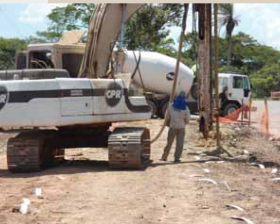
Melhoramento de solo para ampliação rodoviária.
