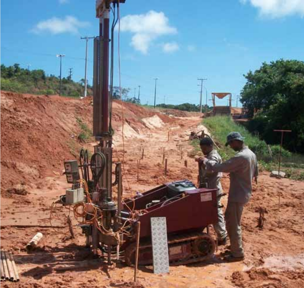
Figura 5 - Outra sondagem CPT-U efetuada em solo mole geoenrijecido. Interrupção prematura da sonda. A certificação foi realizada com pressiómetro.
