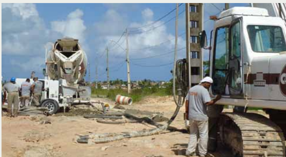
Figura 2 - Melhoramento de solo mole realizado para construção de uma estrada.
