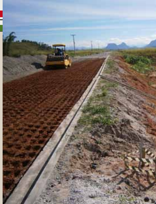
Elevação de um aterro para uma rodovia marginal.
