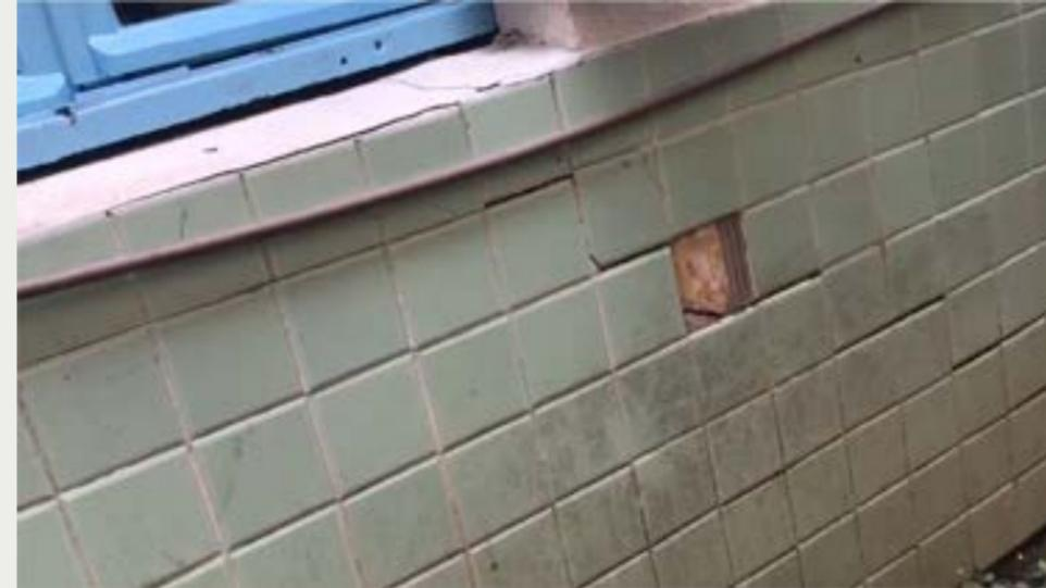
Figura 6 - Trincas escalonadas obedecendo o padrão da cerâmica.
