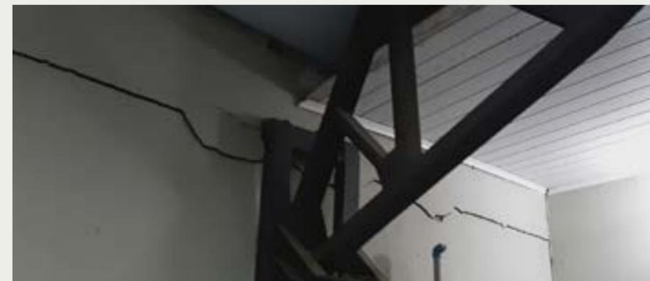
Figura 8 - Ausência de suporte sob a alvenaria da parede faz com que deforme recalcando e perdendo contato com a viga superior.
