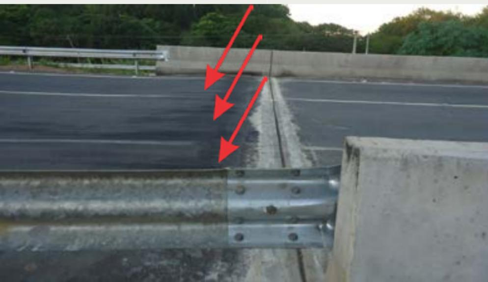
Figura 1 - Um processo de ressalto neste aterro de encontro desta ponte. Observar as setas que informam o recalque da laje de transição.
