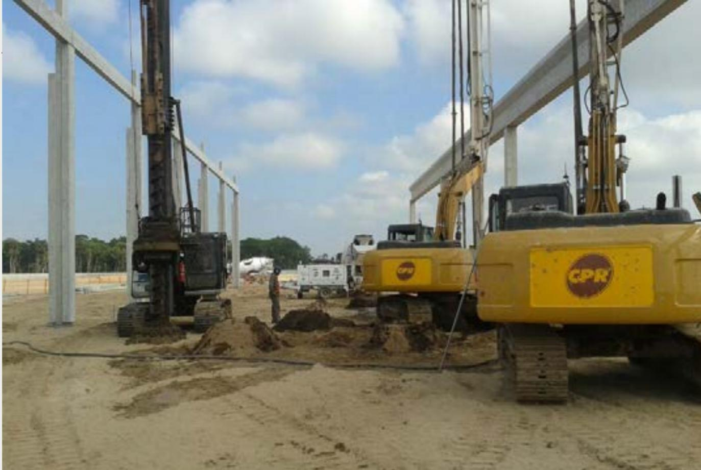
Figura 8 - Três frentes de serviço de geoenrijecimento de solos foram necessários para atender o apertado cronograma da obra, e a grande área a ser geoenrijecida.
