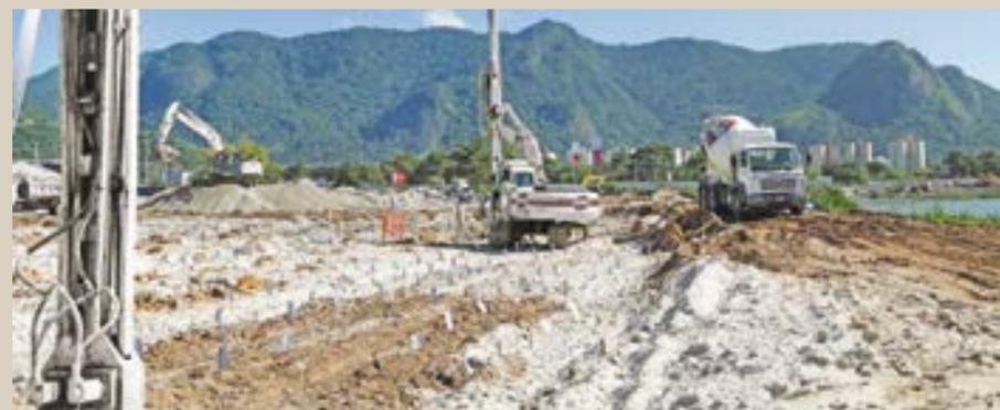
O aterro de conquista lançado sobre solos ultra-moles na Cidade do Rock, no Rio de Janeiro. Houve necessidade de se instalar um geocomposto para dar estabilidade ao aterro de conquista. O Geoenrijecimento sendo realizado.
