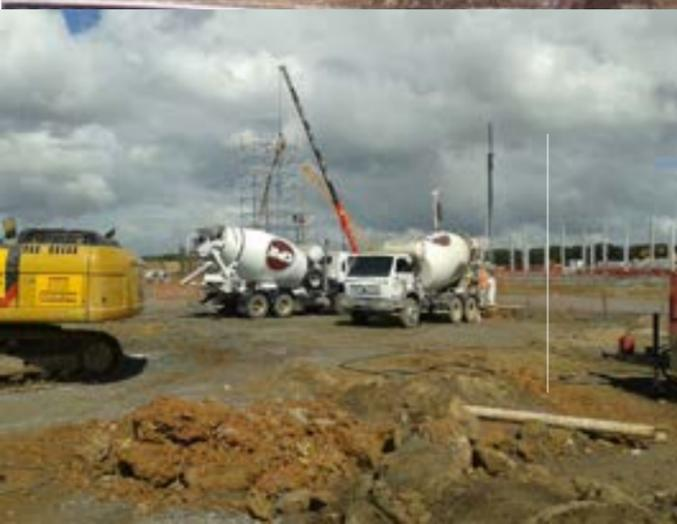
Figura 1 - A presença de solo mole tornou necessário serviços de geoenrijecimento para construção da fábrica de carros estrangeiros, no sul do país.
