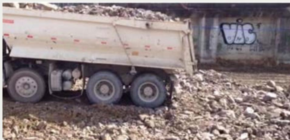
Figura 4 - Na continuidade, a qualidade do material do aterro é diversificada, começando com uma espécie de rachão. O processo de compactação simplesmente não existe.
