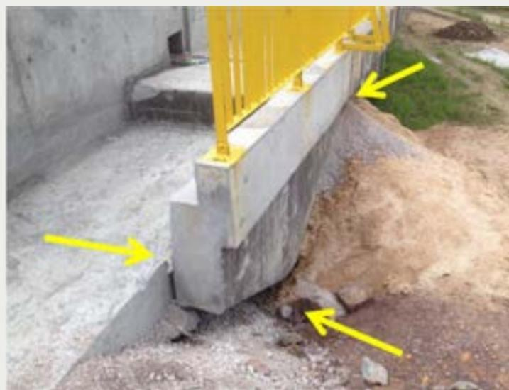
Figura 7 - Juntas e brechas nas quais a água infiltra no aterro. Nesta foto, estes locais estão sendo preenchidos com aterro. Forte erosão sob a laje de transição. Percebe-se que a laje está deformando sobre o solo suporte
