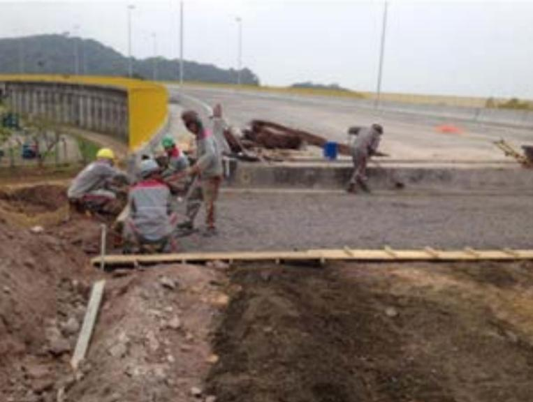
Figura 5 - Fôrma e armação da laje de transição apoiada sobre aterro completamente heterogêneo e com matéria orgânica, conseqüentemente difícil de obter grau de compactação adequado, o que significa recalques futuros.
