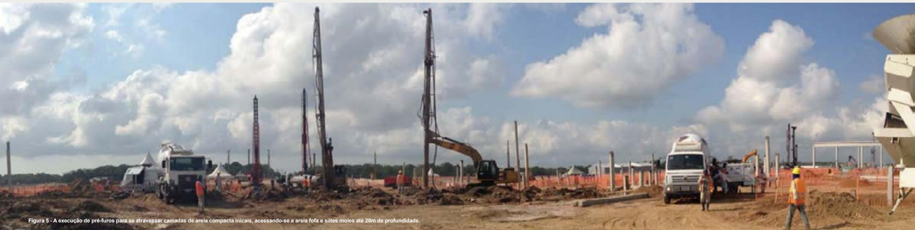
Figura 5 - A execução de pré-furos para se atravessar camadas de areia compacta iniciais, acessando-se a areia fofa e siltes moles até 20m de profundidade.
