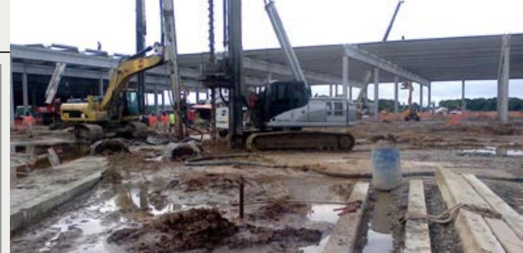
Figura 6 - Geonrijecimento do solo de fundação, devido a presença de depósitos de areias fofas e siltes/ argilas moles com 20m de profundidade.
