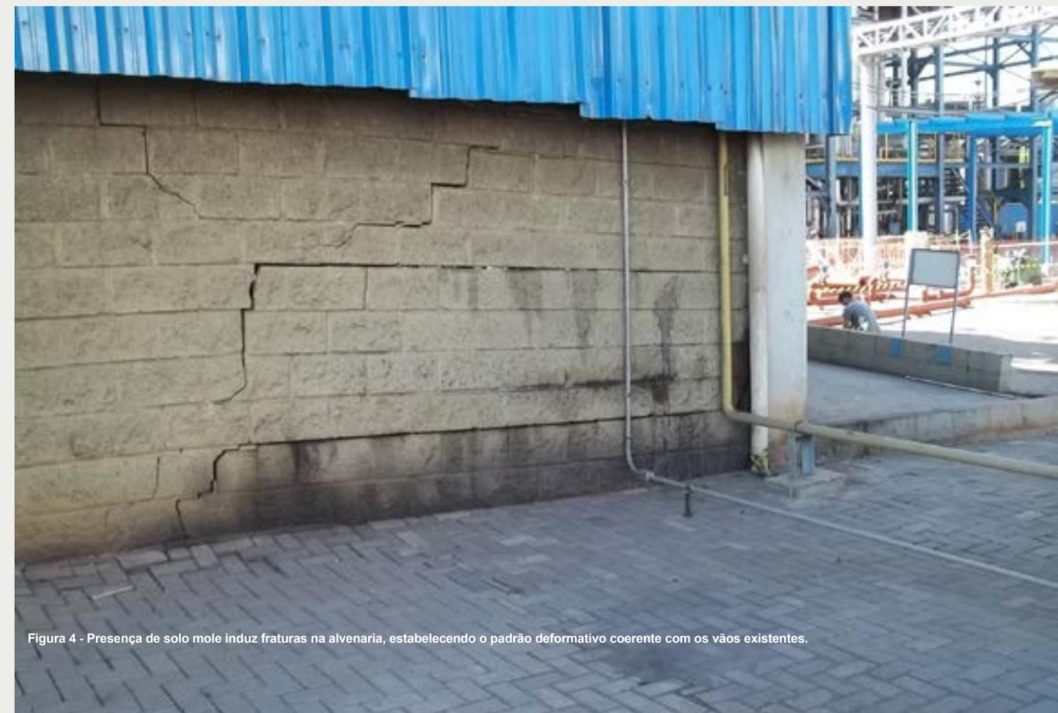
Figura 4 - Presença de solo mole induz fraturas na alvenaria, estabelecendo o padrão deformativo coerente com os vãos existentes.
