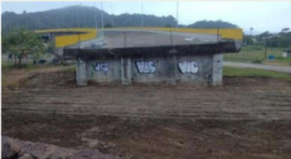
Figura 3 - Pode-se observar, neste início do aterro de acesso a esta ponte, que o solo empregado apresenta condição imprópria.
