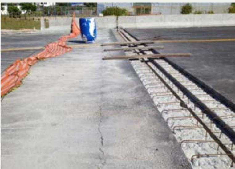
Figura 6 - Fissuras/trincas na junção da laje de transição com a viga console, devido ao recalque do aterro suporte, que permite a entrada d'água, que piora ainda mais os sintomas
