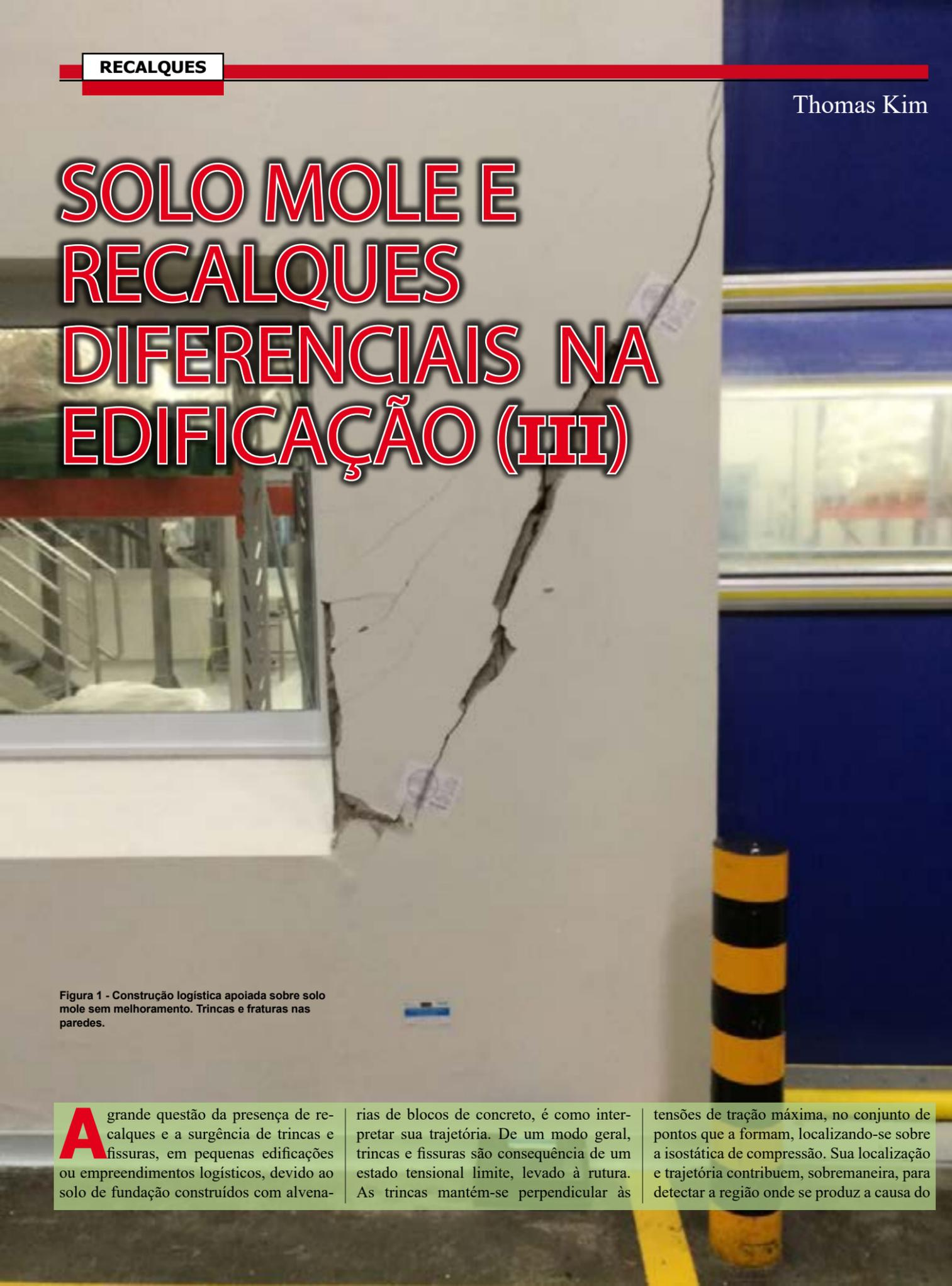
Figura 1 - Construção logística apoiada sobre solo mole sem melhoramento. Trincas e fraturas nas paredes.
