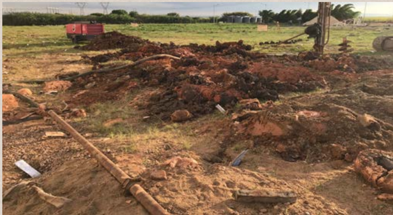
Figura 2. A presença de pedregulhos no aterro, costuma dificultar a cravação de geodrenos no solo mole, para iniciar o melhoramento do solo mole.
