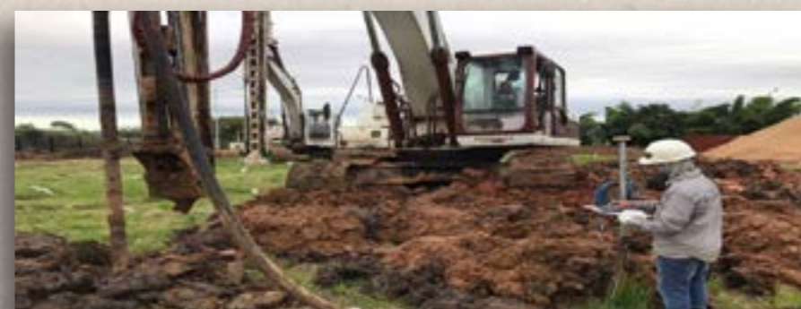
Figura 6 - Presença de aterros "sujos" é uma constante ao longo das grandes áreas, o que dificulta o trabalho de melhoramento do solo mole
