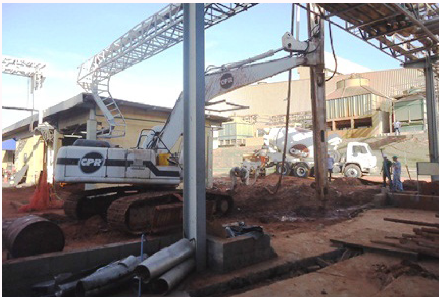
Figura 2: Serviços de geoenrijecimento do solo de fundação com geoenrijecimento para interromper extenso processo de recalque em uma indústria no município de Lins SP
