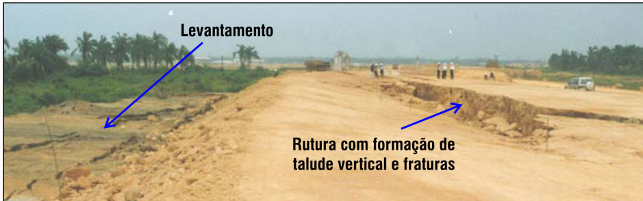
Figura 5: Segunda ruptura do aterro, melhorado inicialmente com pré carregamento à vácuo, utilizando-se geodrenos e, a seguir, melhorado com coluna de brita (Gue et.al.2001)
