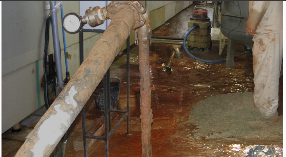
Figura 8 : Intervenção, com geoenrijecimento do solo, para parar processo de recalque no interior de uma indústria em Sorocaba SP
