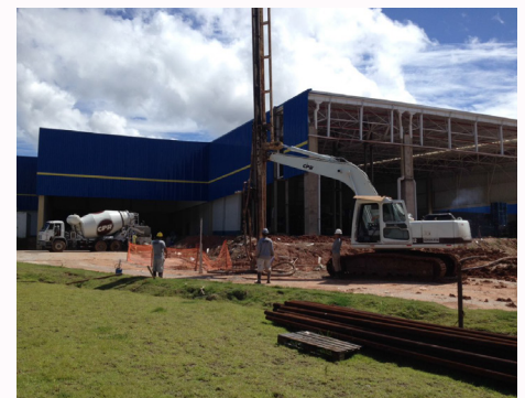
Figura 7: Intervenção, com geoenrijecimento do solo, para parar o processo de recalque motivado pelo lançamento de aterro sobre solo mole, em um grande hipermercado
