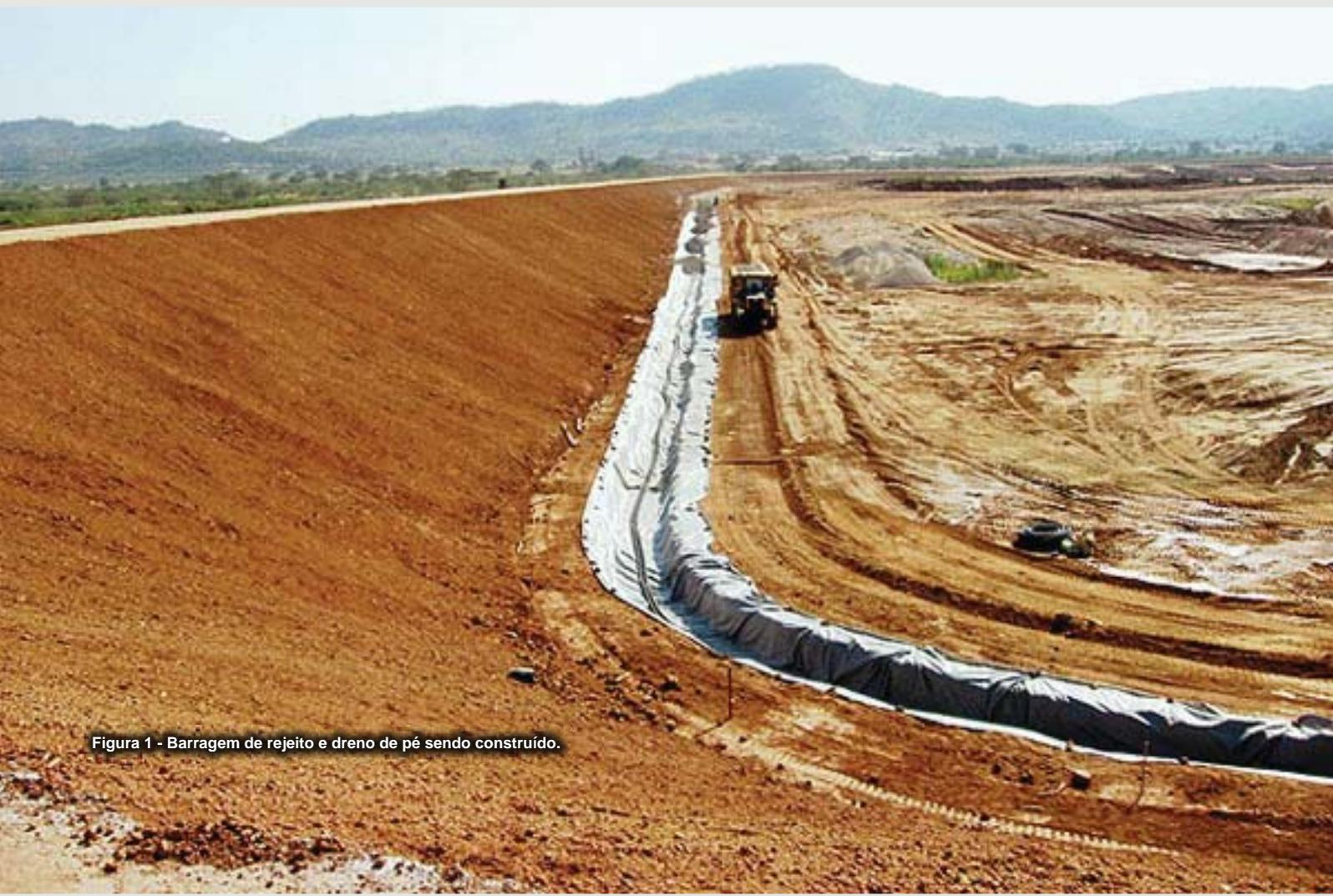
Figura 1 - Barragem de rejeito e dreno de pé sendo construído.
