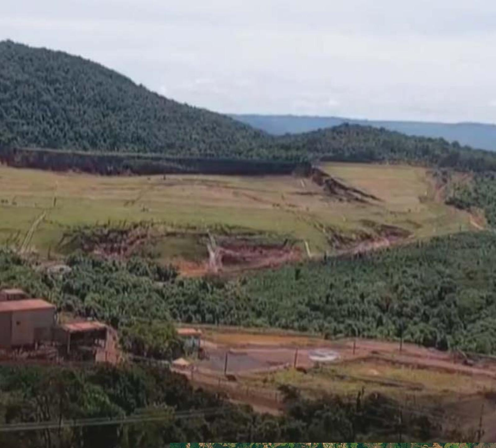
para facilitar o transporte e decantação do rejeito. O próprio rejeito de minério de ferro serviu como base para o alteamento de diques sucessivos, elevando-se a altura do reservatório.
