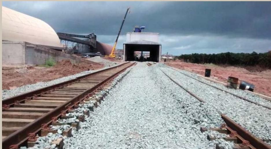
O lastro é a camada de material granular que fica entre o sublastro e os dormentes, mantendo a superestrutura drenada, distribuindo a pressão exercida pelos dormentes à infra-estrutura. Trecho de ferrovia executada no Porto do Itaqui, São Luís, MA, após o melhoramento do solo com Geoenrijecimento.
