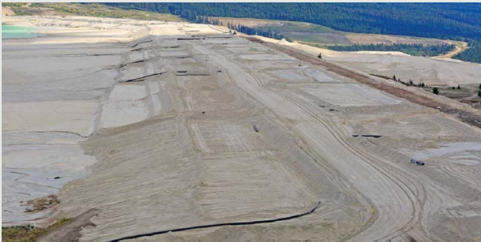
Figura 9 - Barragem de rejeitos sendo elevada em mina de cobre.
